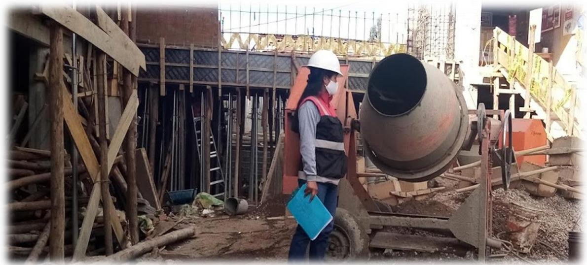
*Fotografía 17.* Mezclado de materiales para la elaboración de probetas cilíndricas- las probetas se elaboraron en obra.
