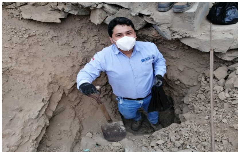
Figura N°30. Ejecución de calicata
