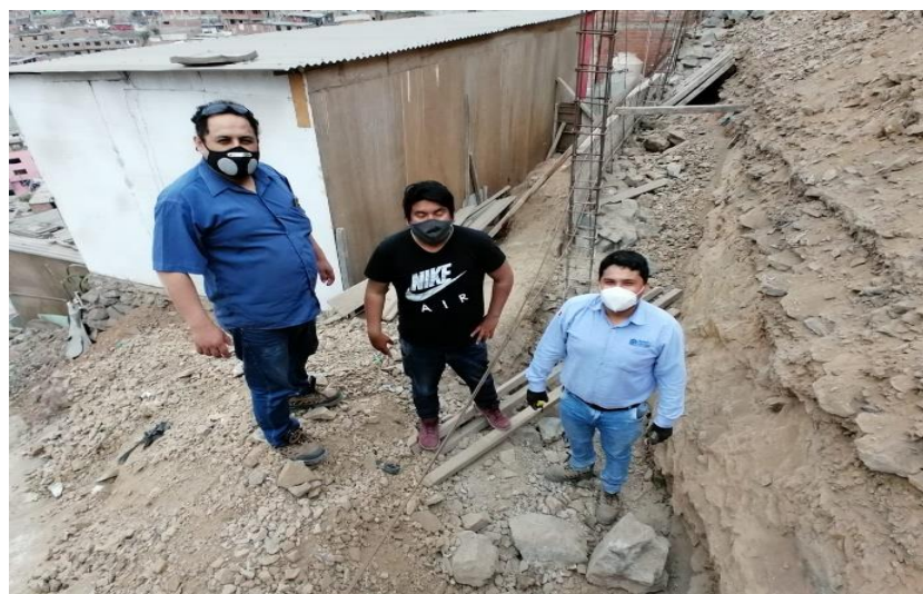
Figura N°31. Ejecución de calicata
