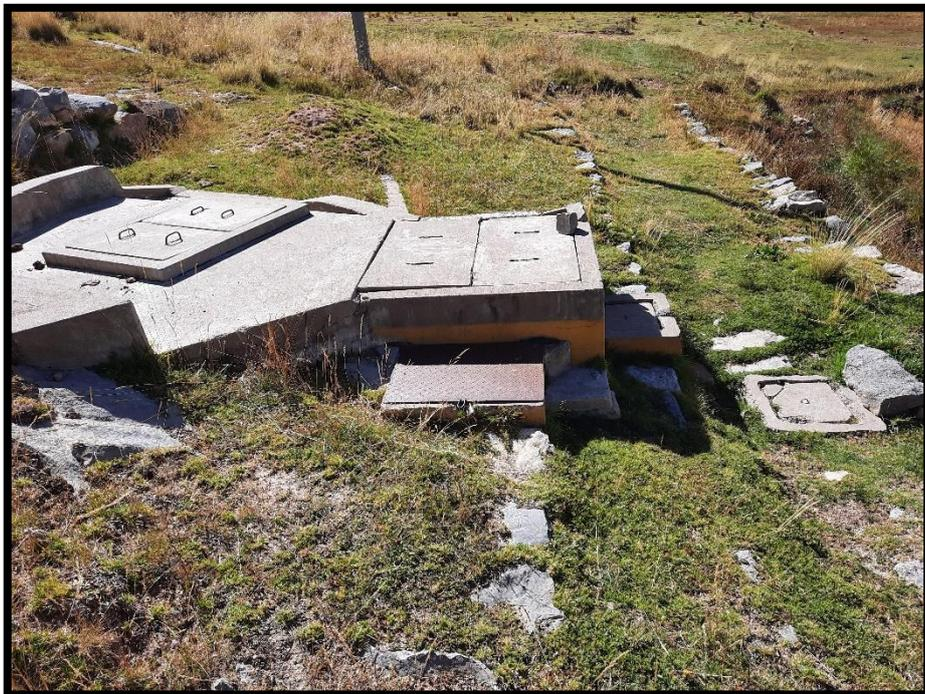
**Fotografía N° 6:** Estructura de la Cámara de Rompe Presión Tipo 7 (en mal estado)
