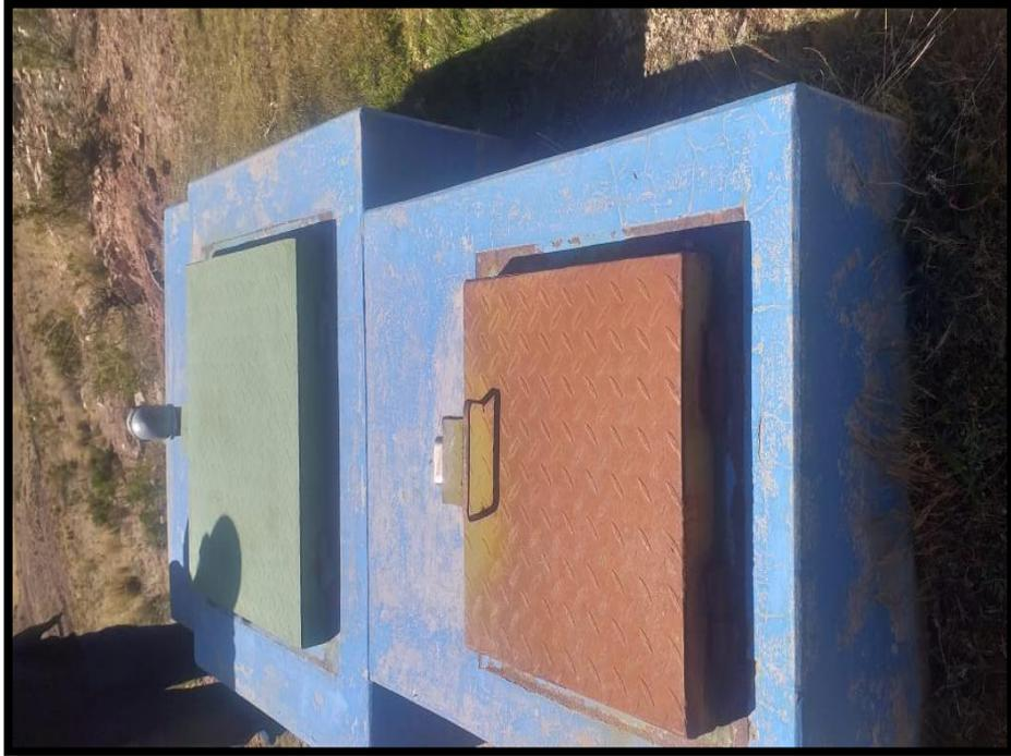
**Fotografía N° 7:** Estructura de la Cámara de Rompe Presión Tipo 7 (Regular estado)
