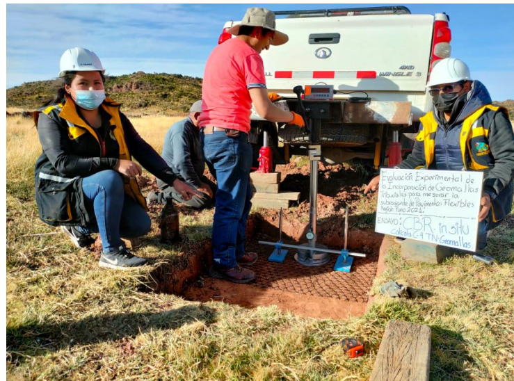
Figura 30. Aplicación de carga a la subrasante
