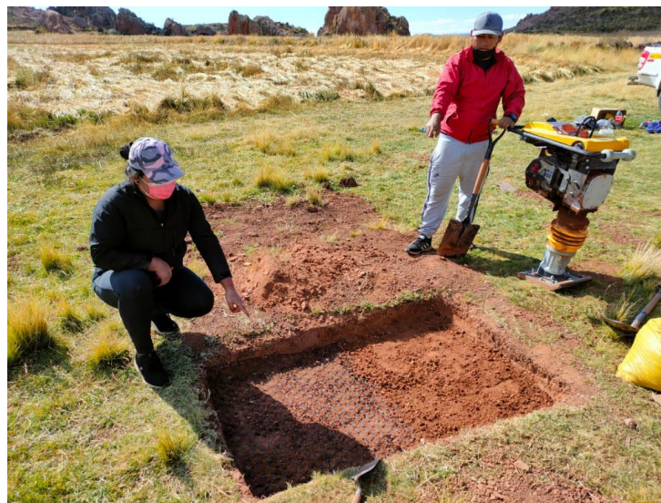
Figura 27. Colocación de la geomalla triaxial
