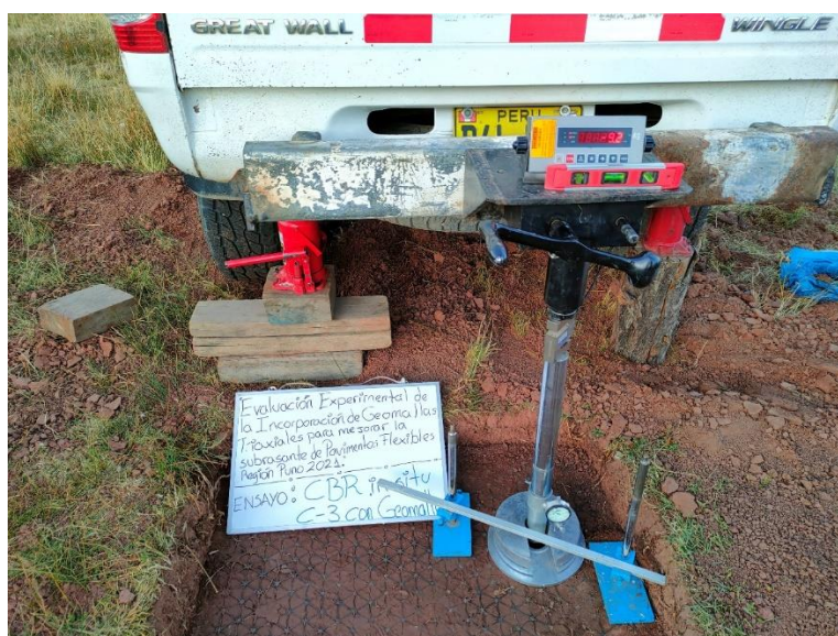
Figura 29. Verificación del nivelado del terreno
