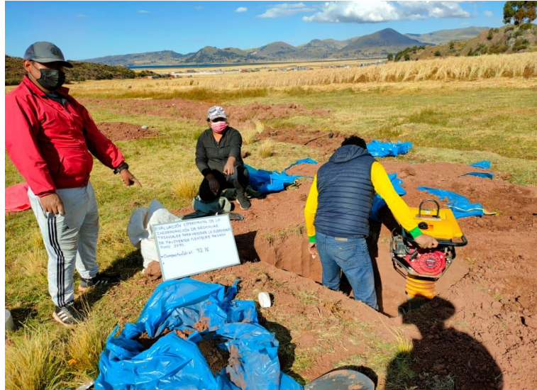
Figura 26. Compactación de la subrasante
