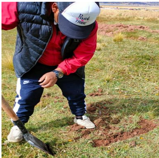
Figura 13. Limpieza de la zona de excavación
