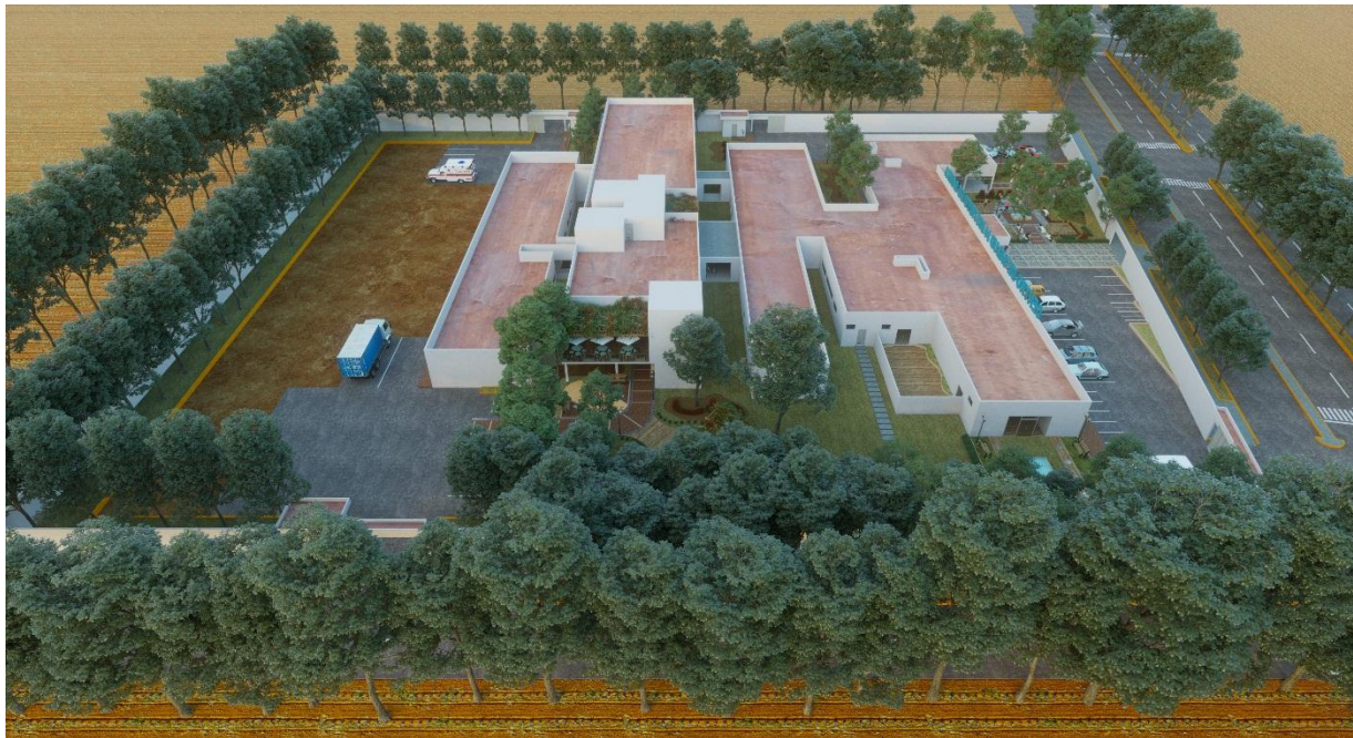
Figura N° 63 VISTA AÉREA LADO IZQUIERDO DEL PROYECTO C.S
