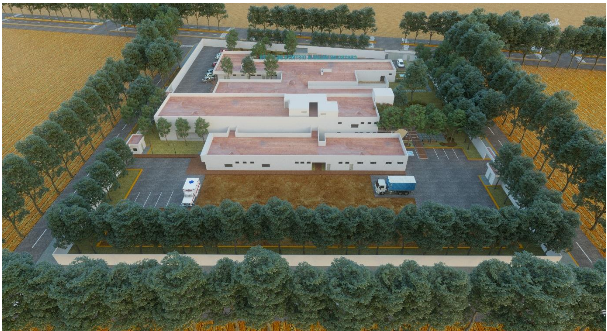
Figura N° 61 VISTA AÉREA LATERAL DEL PROYECTO C.S
