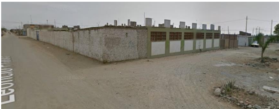
IE N° 82073 San Martín de Porres ubicado en la calle Leoncio Prado
