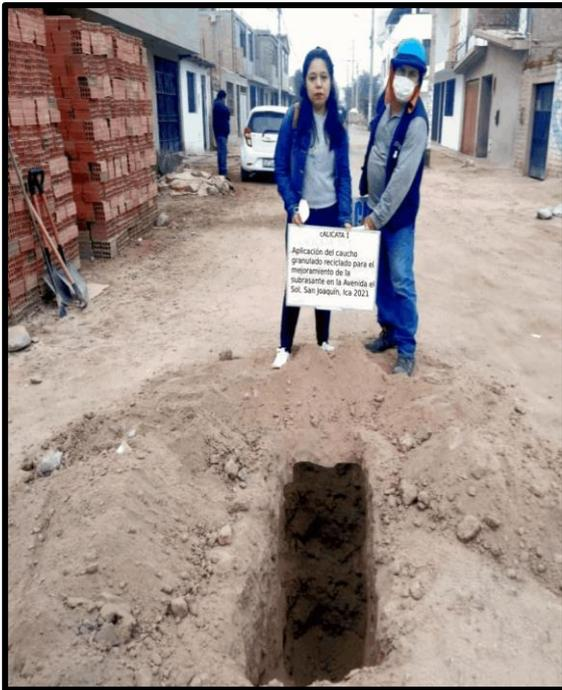
Figura 23. Excavación de calicata 1.
