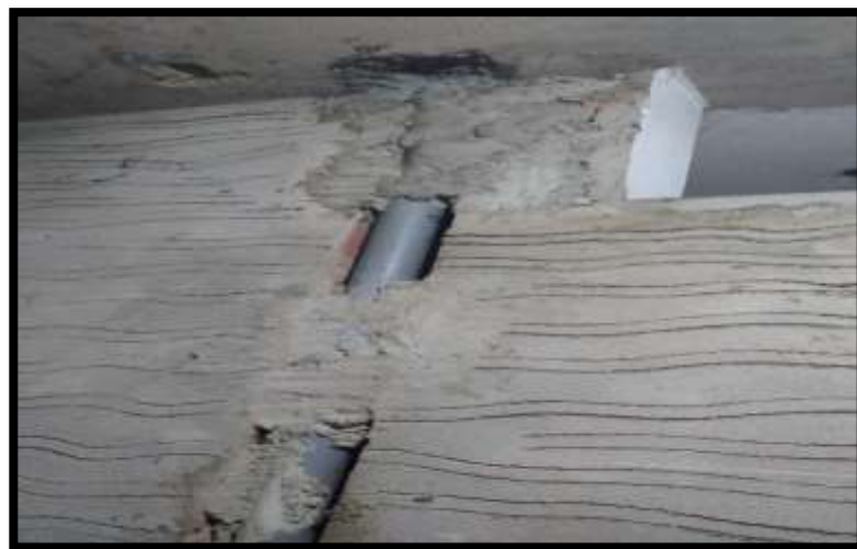
Bajante en muro portante
