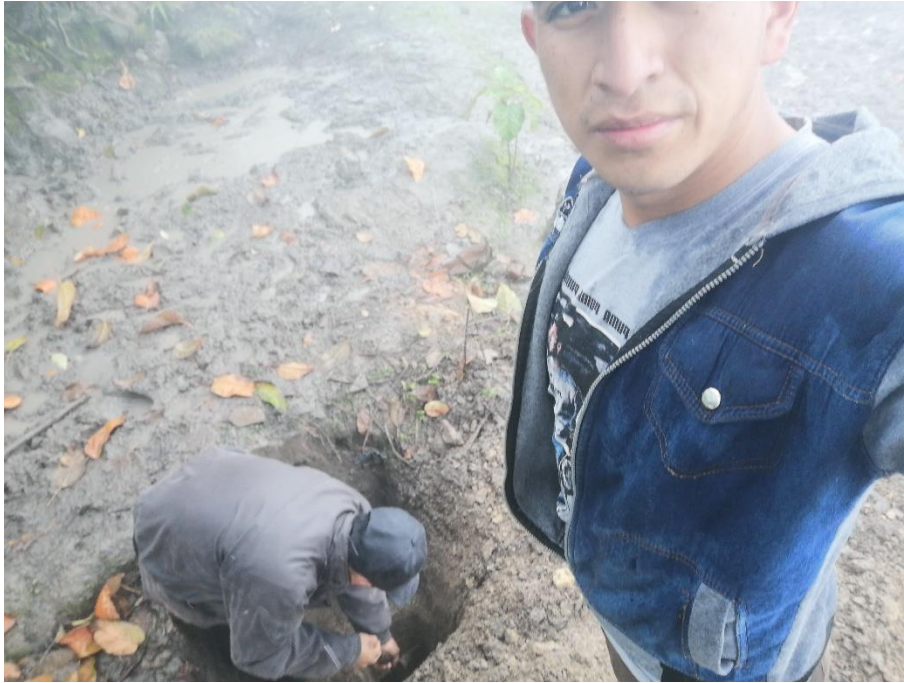
Realizando trabajos de excavación de calicata C-2
