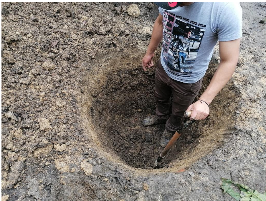
Realizando trabajos de excavación de calicata C-1
