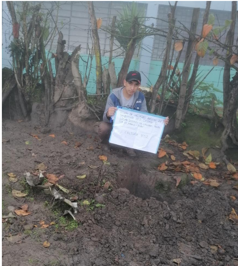
Realizando trabajos de excavación de calicata C-2
