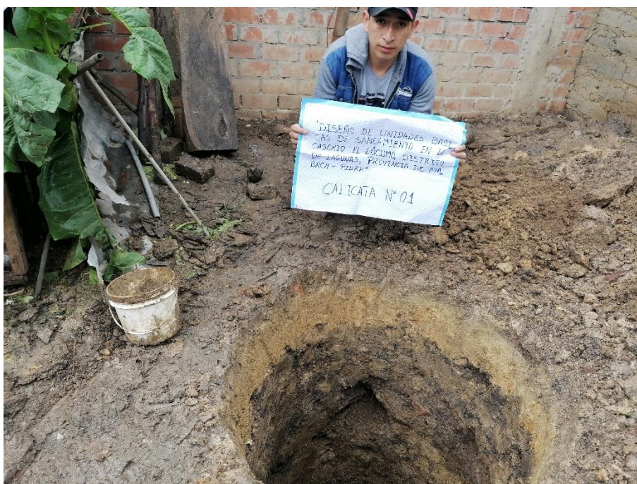
Realizando trabajos de excavación de calicata C-1
