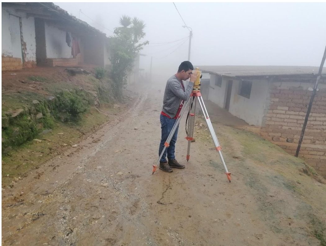
En la imagen se aprecia tomando lectura para lanzar la señal de laser
