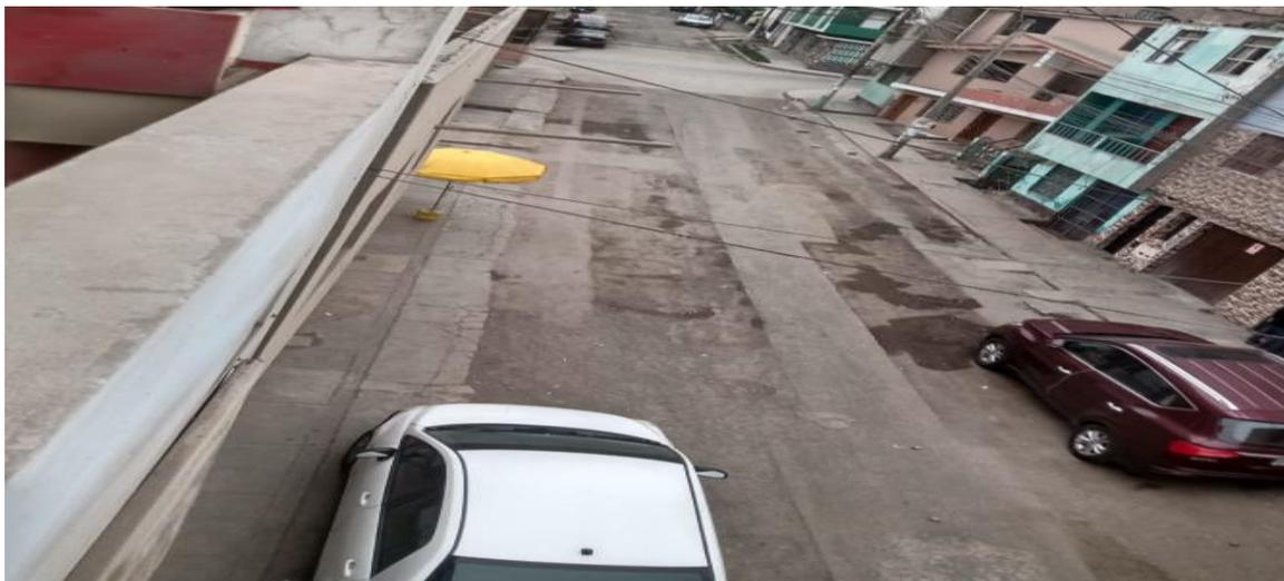
**Figura 4.** Deterioro de pavimento flexible. Fuente: Elaboración propia
