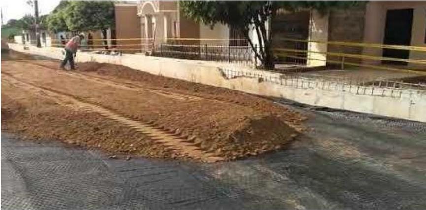
**Figura 6.** Visualización de la subbase granular. Fuente: Google
