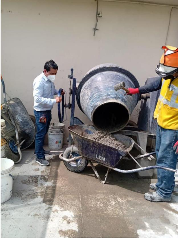
**Figura 27.** mezclado en el rodillo. Fuente: Elaboración propia
