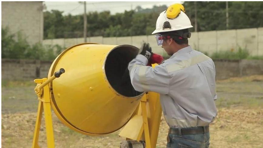
**Figura 4.** Dosificación del concreto. Fuente: Google
