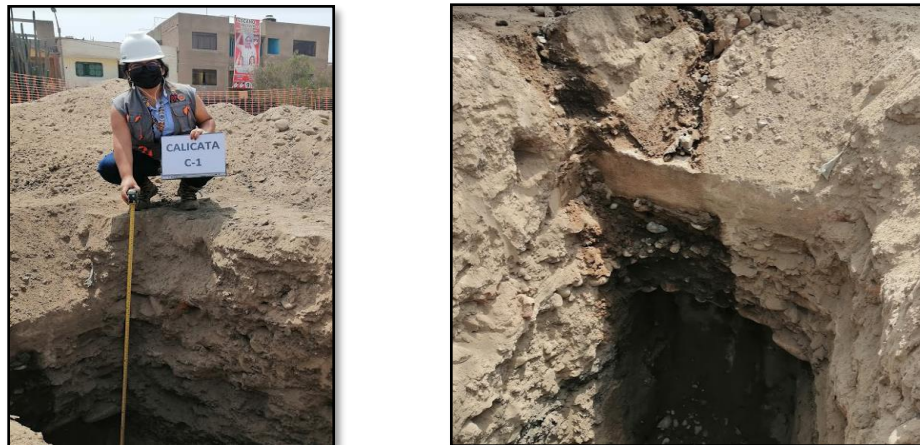
Figura 15. Elaboración de calicata 1
