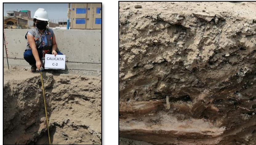
Figura 16. Elaboración de calicata 2
