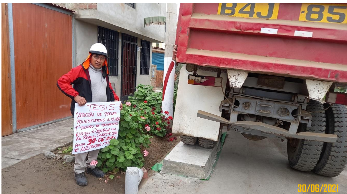
Figura 87: Se muestra la prueba de la deformación real en campo, mediante un vehículo de peso de 20TN, en donde claramente el pavimento no sufre deterioros (no se observa ninguna rajadura ni fisuras en el bloque del concreto).
