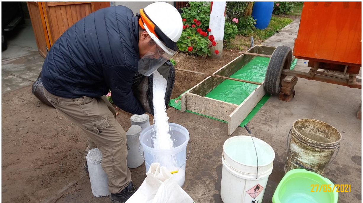
Figura 81: Se muestra la adición de las perlas de poliestireno en el diseño de mezcla previas al vaciado del pavimento rígido f'c=280\text{kg/cm}^2 con adición de 18% perlas de poliestireno, en la av. Ramos Cañete; así mismo se muestra el encofrado de la losa pavimento rígido.
