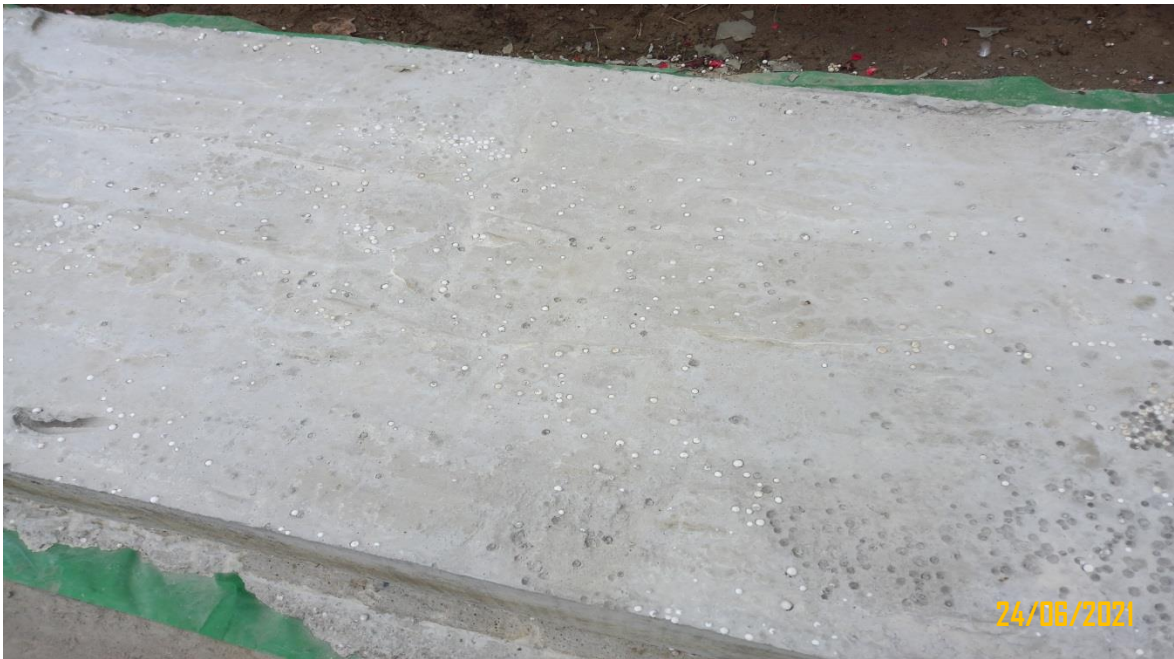
Figura 84: Se muestra el pavimento rígido de dimensiones de 2.50m x 0.60m x 0.22cm, con adición de perlas de poliestireno de 18%.
