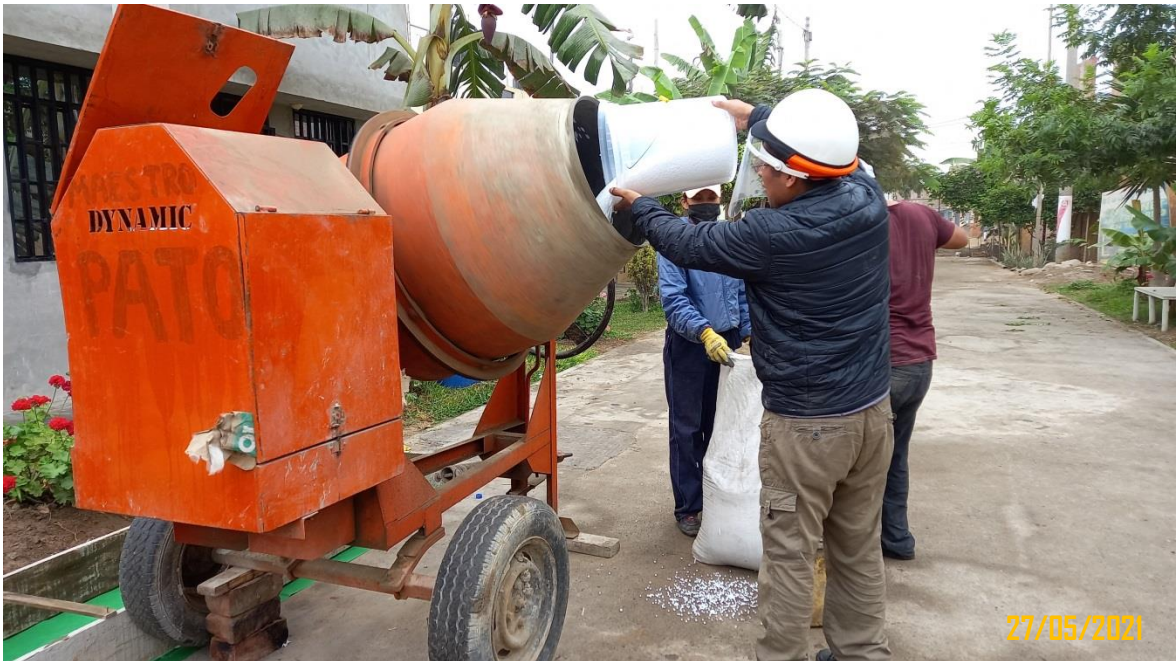
Figura 82: Se muestra la mezcla correspondiente en la mezcladora el concreto el vaciado del concreto f'c=280\text{kg/cm}^2 con adición de 18% perlas de poliestireno.
