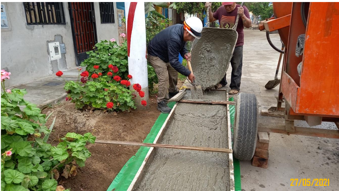
Figura 83: Se muestra el vaciado del concreto preparado en el molde de dimensiones 2.5m x 0.6m, esto con fines que una vez se cumpla con el curado con agua y a los 28 días, sea sometida a la prueba de la deformación real en campo, mediante un vehículo, con el fin de identificar que si el pavimento pueda sufrir deterioros, fisuras.
