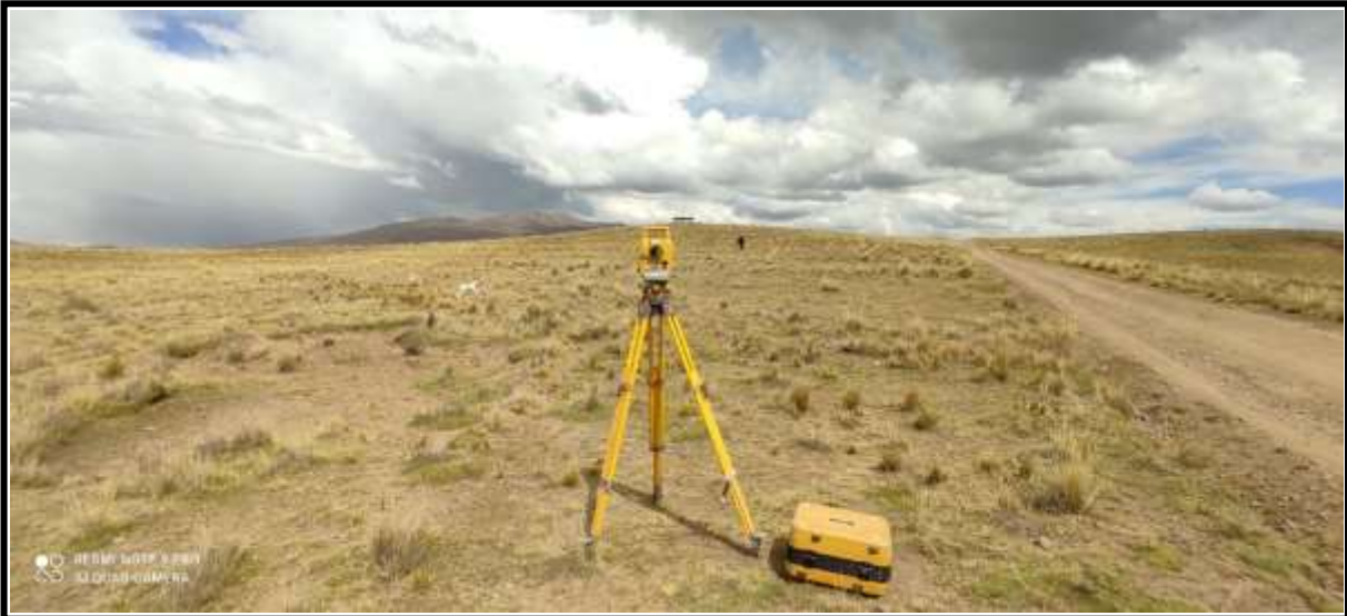
Fotografía 05: Lectura de vista hacia adelante con referencia al tanque de agua existente.
