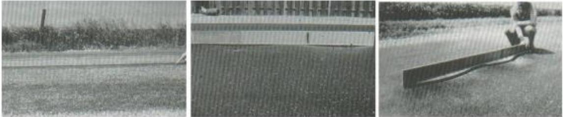
Figura N° 2: Falla de tipo coorugación.
