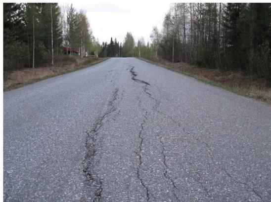
Figura N° 09: falla tipo grietas longitudinal en pavimento flexible.
