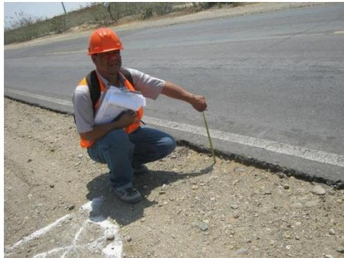
Figura N° 07: Falla de tipo desnivel de berma
