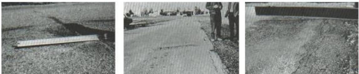
Figura N° 06: Falla de tipo ahuellamiento.
