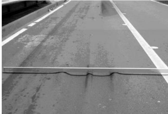
Figura N°04. Falla de tipo ahuellamiento
