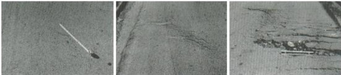
Figura N° 10: Falla de tipo grietas parabolitas
