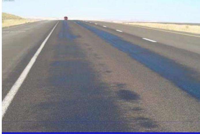
Figura N°05. Falla de tipo exudación.
