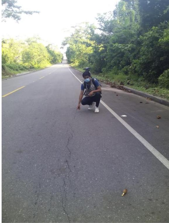
Imagen: Falla tipo grieta longitudinal.
