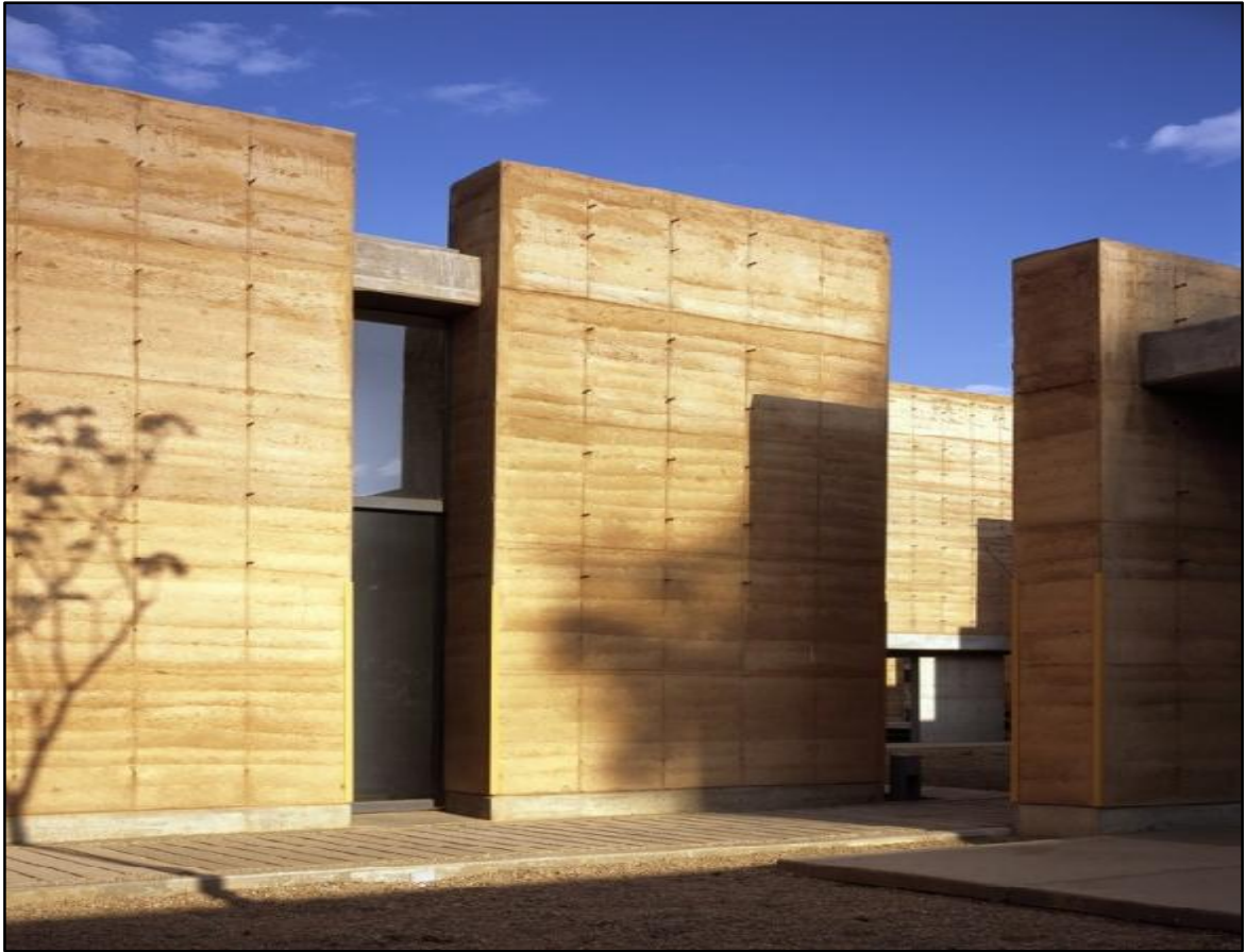
Figura 38 : Detalle constructivo con tapial
