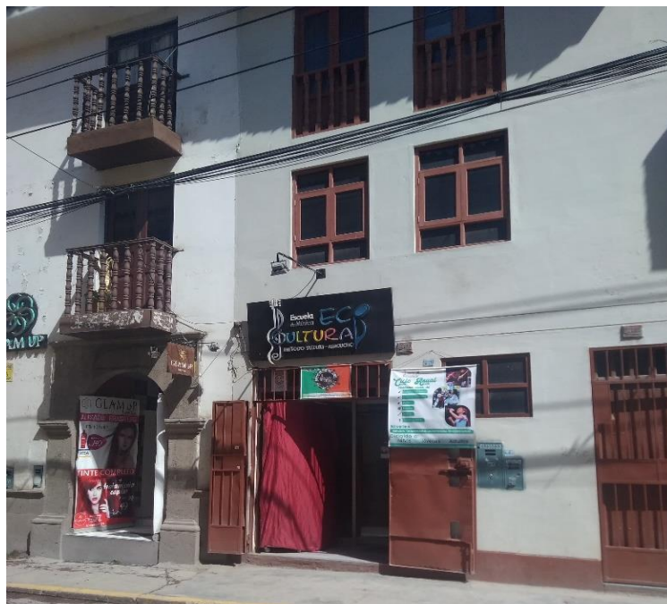
Figura 1. Fachada de la escuela de música Eco Cultural
