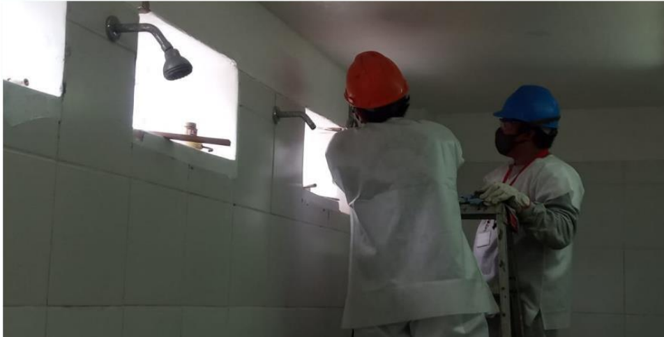
Figura 11. Eliminación de focos de contaminación
