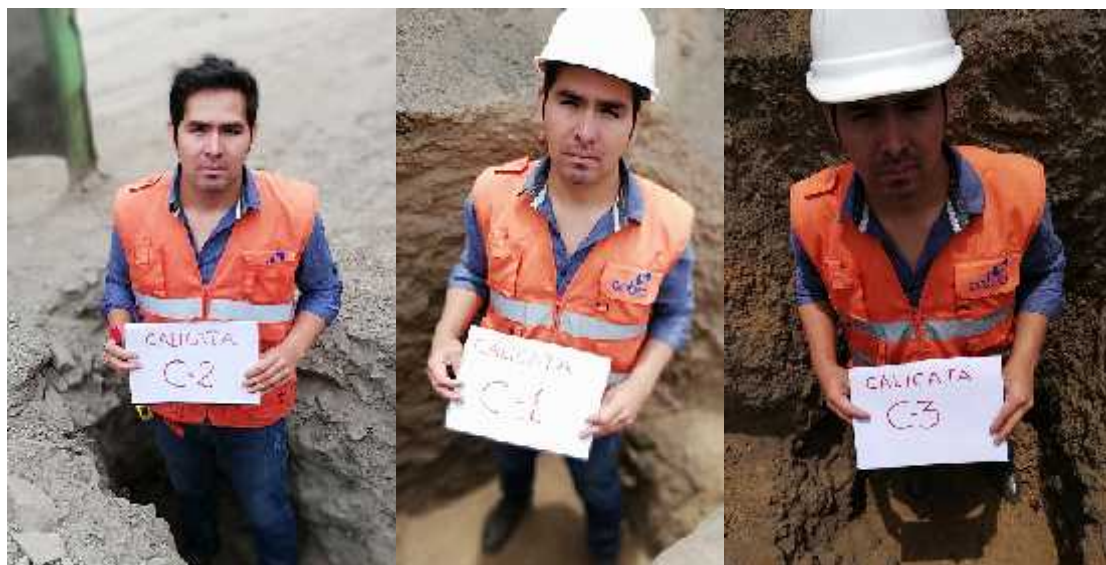
Figura 14. Calicatas C1, C2, C3
