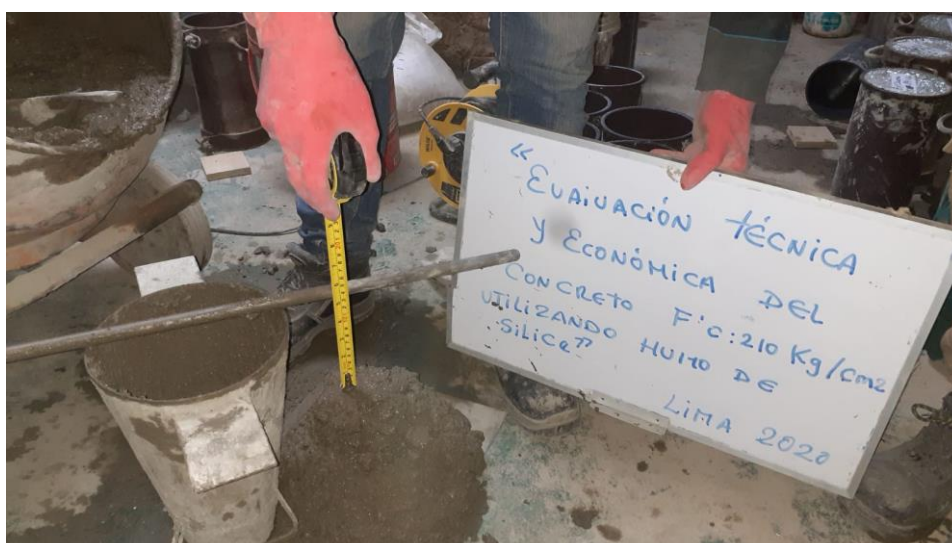
Figura 09. Realizando ensayo de cono de abrams.
