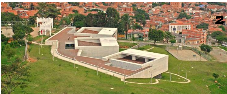
Foto 2: Parque biblioteca Leon de Greiff
