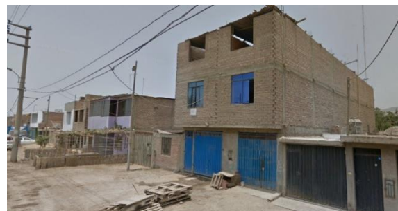
Figura 86: Fotografía desde la avenida María Parado de Bellido
