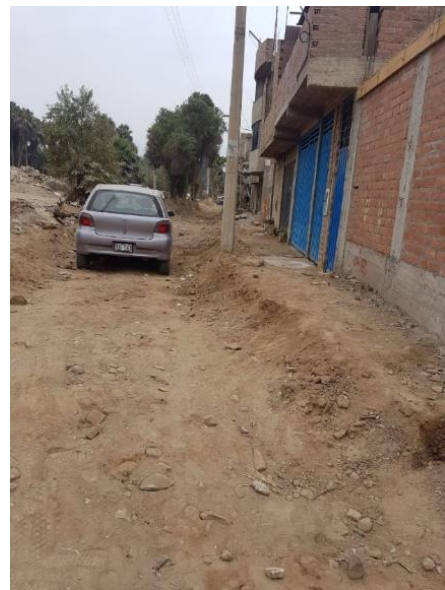
Figura 13: Fotografía desde la calle los huertos de pro Fuente: Elaboración propia
