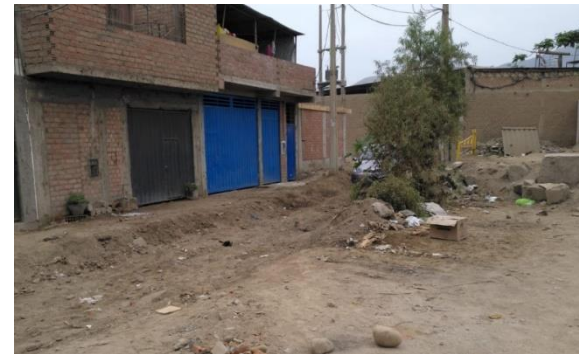
Figura 12: Fotografía desde la calle los huertos de pro Fuente: Elaboración propia
