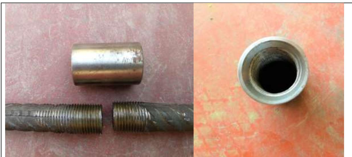
*Comprobación del estado del roscado en varillas con conectores mecánicos sin rotación.*
