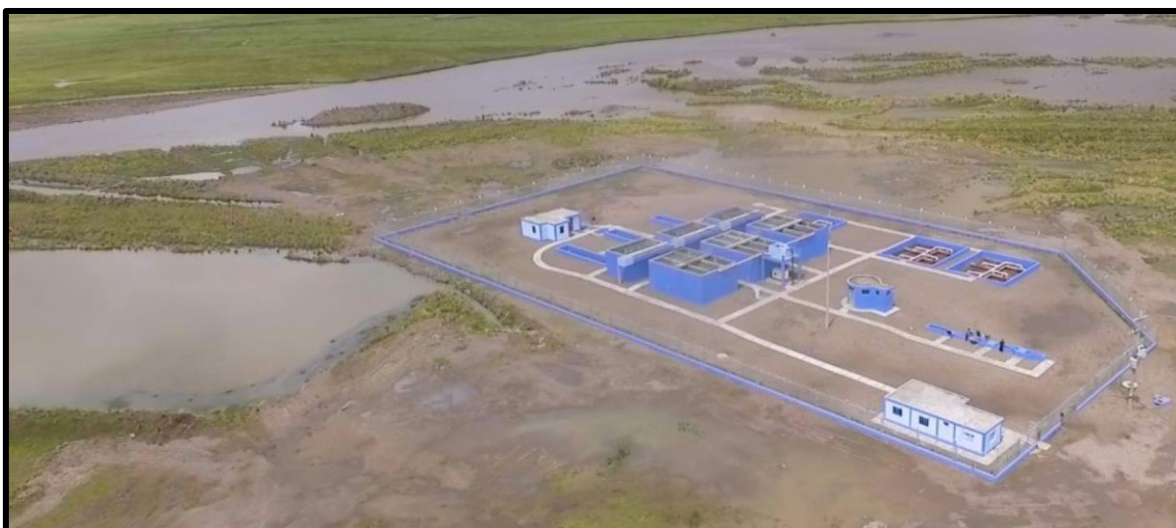
Figura 2. PTAR con un sistema de poca intervención mecánica
