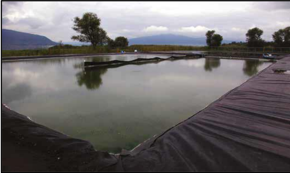
Figura 20. Vista de una laguna de pulimento o maduración
