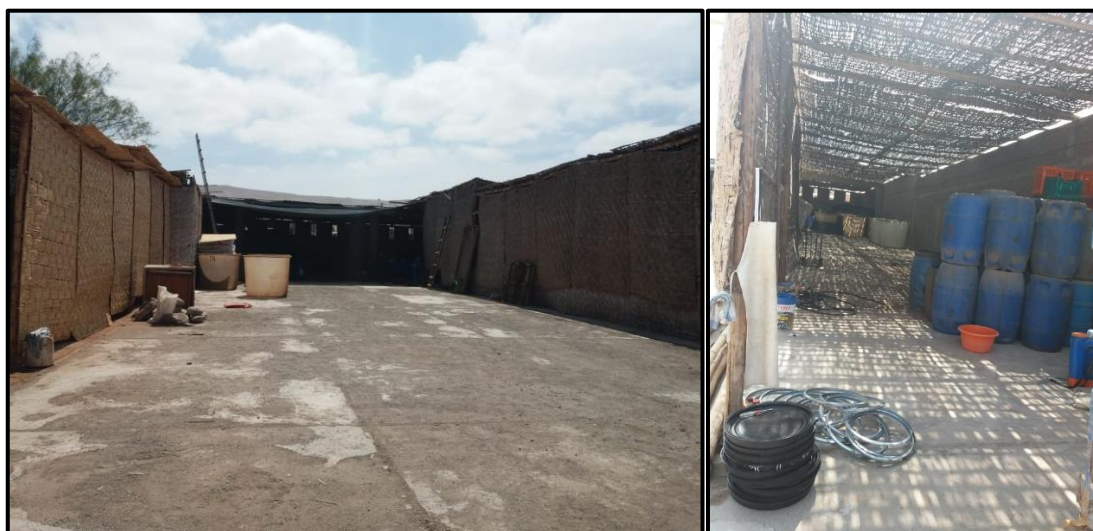
Figura 9. Estructuras que utilizadas para cubrir del sol a los tanques de maceración
