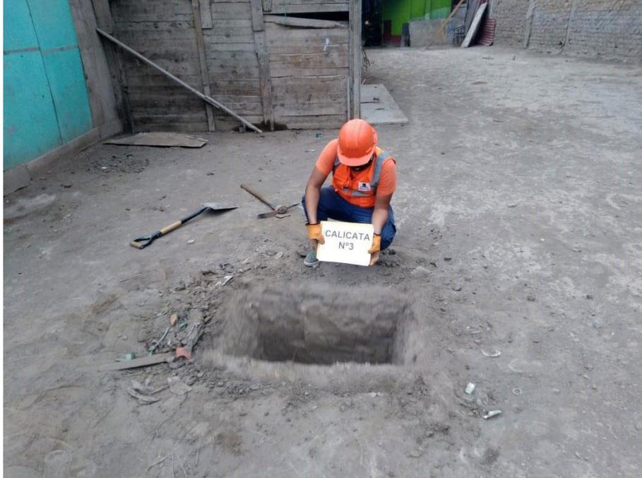
Se alcanzó la profundidad de 2.5 m, donde se encontró un estrato de Arena Limosa, con contenido de humedad bajo, no se encontró presencia del nivel freático.
