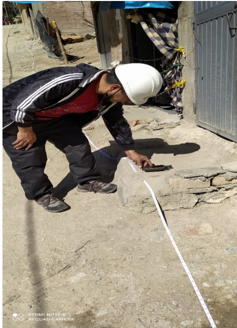
Medición con GPS de la zona del proyecto tramo 2
