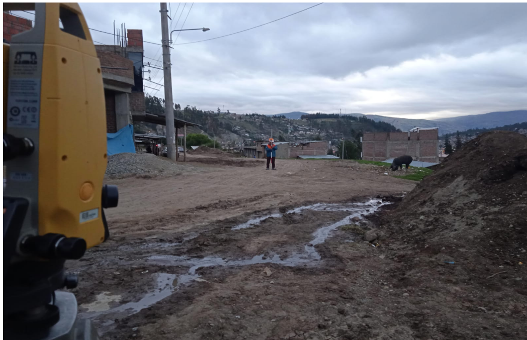
Escorrentía de aguas servidas
