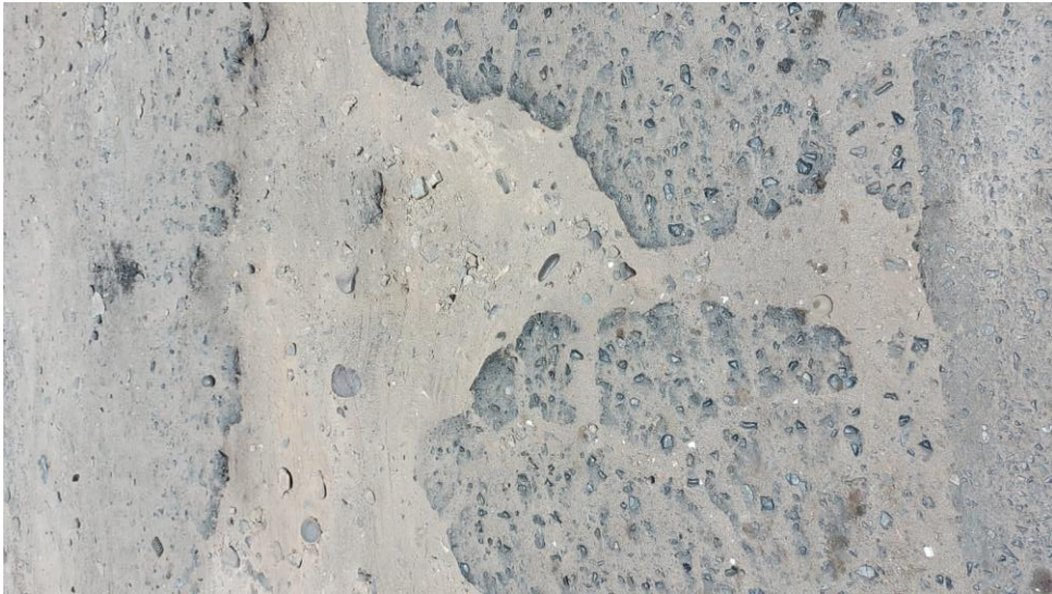
Fuente: Avenida Metropolitana, Ate
