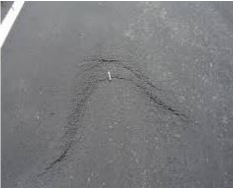
Fuente: Avenida Metropolitana, Ate
