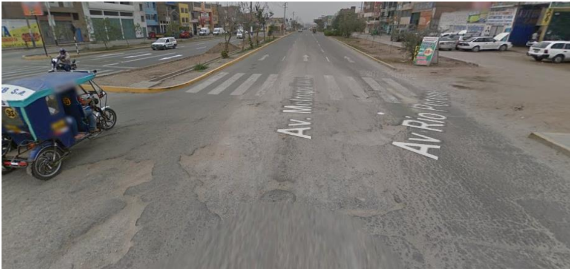
Figura 4: tramo de la Av. Metropolitana, Ate.
