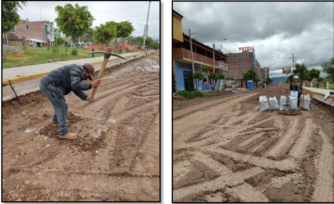
Figura 45: Ubicación de calicata C-1
