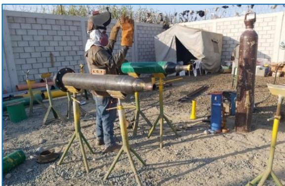
Figura. 29. Soldadura de tuberías - Fuente: Propia.
