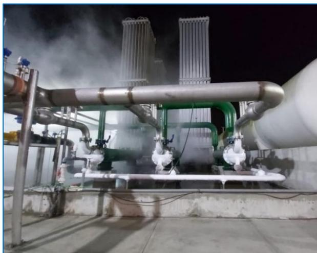
*Figura. 35. Vaporizadores forzados funcionando - Fuente: Propia.*
