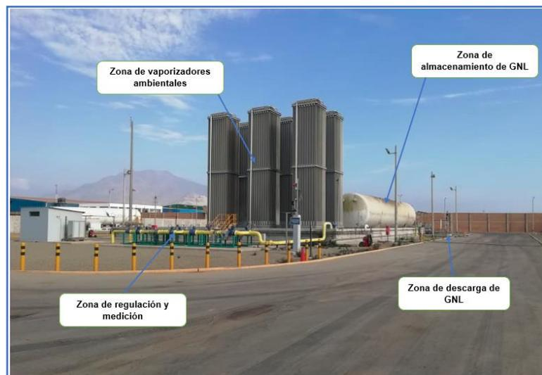
*Figura. 2. Planta de regasificación de GNL - Fuente propia*
