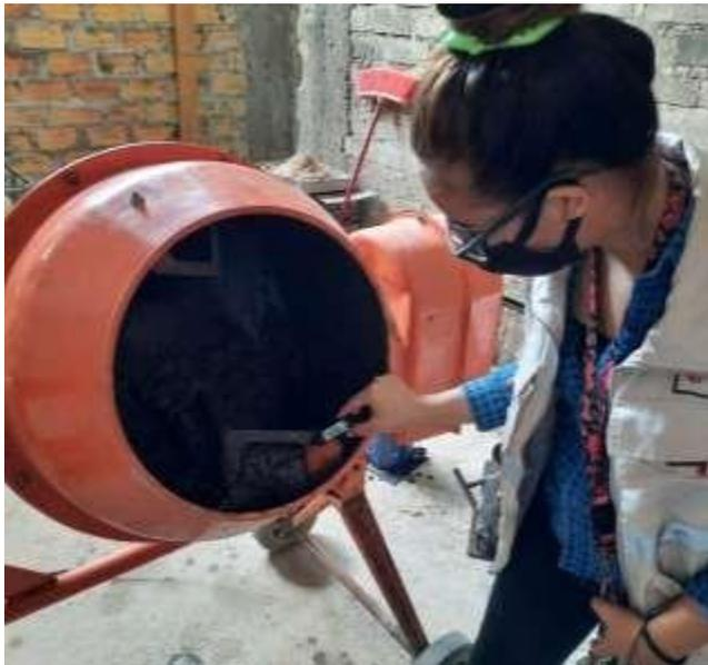
**Figura 23:** Verificando la temperatura del concreto
