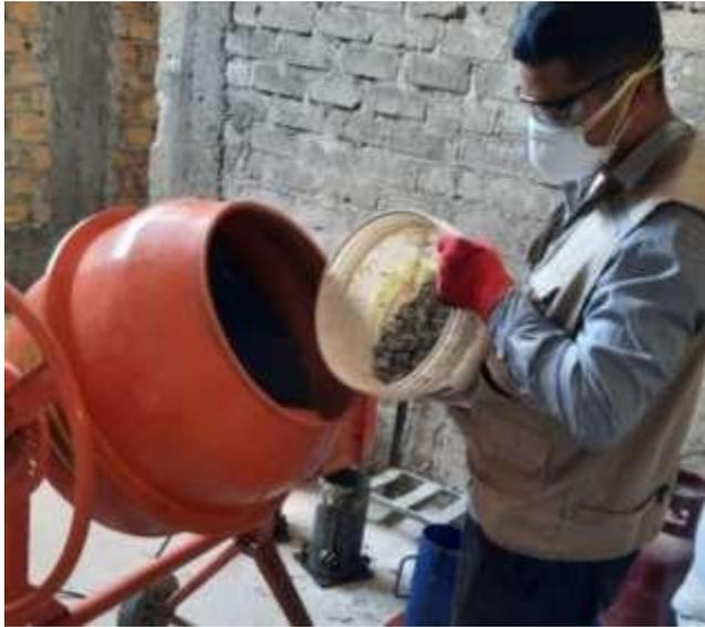
**Figura 21:** Mezclando los componentes del concreto
