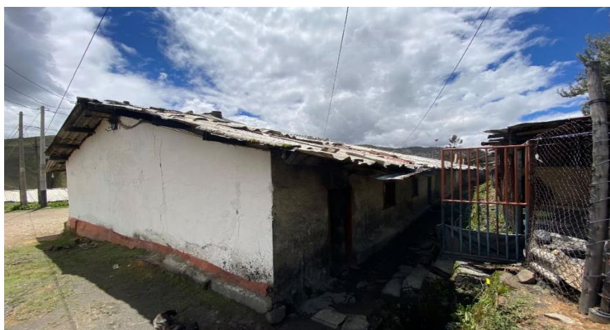
Figura 2. Sistema constructivo predominante.
