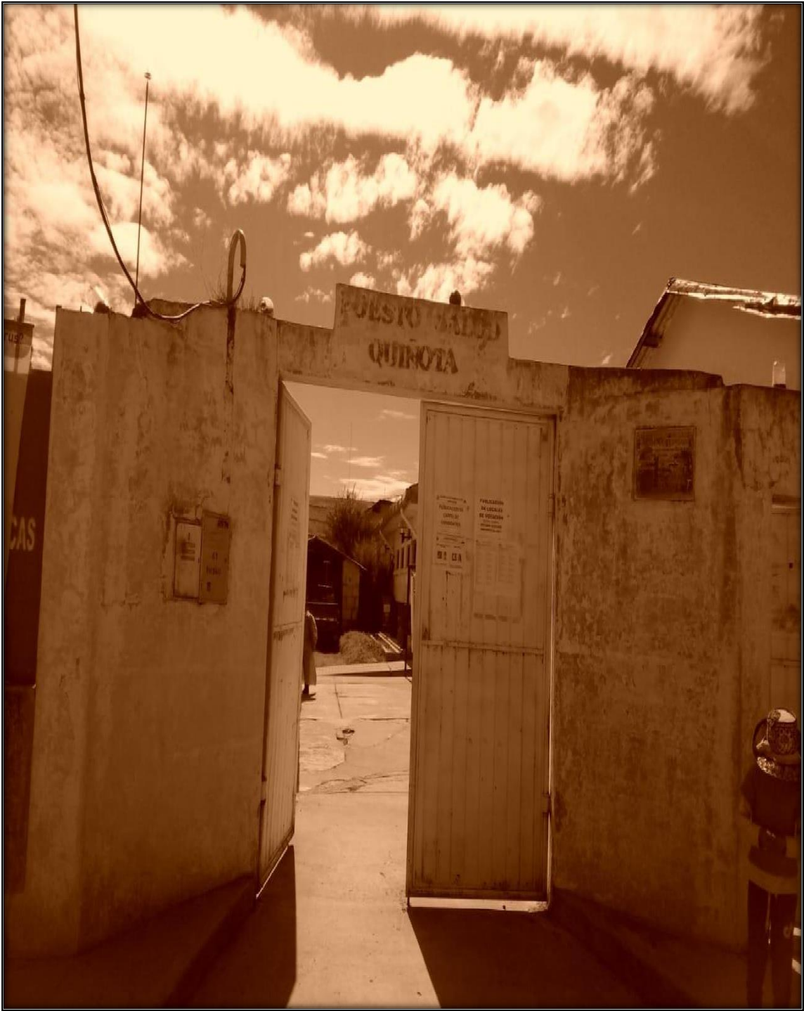
Fig. 1 Puerta de acceso al puesto de salud
