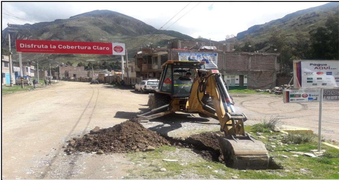
Fig. 45. Excavación de calicata 01
