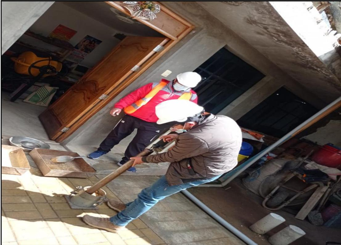
Fig. 69. Realizando apizonamiento para determinar la compactación o densidad máxima del suelo
