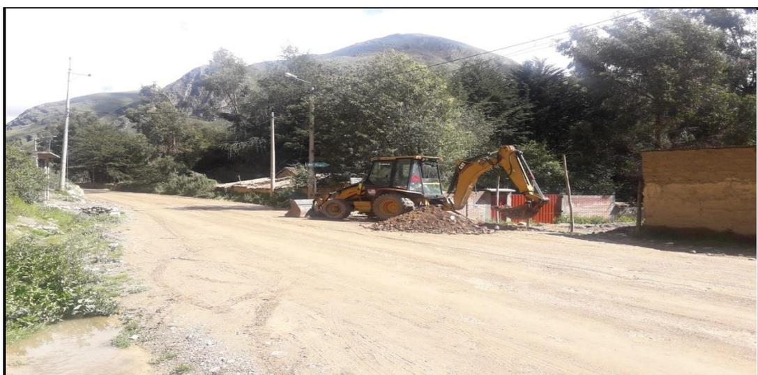
Fig.46. Excavación de calicata N°02
