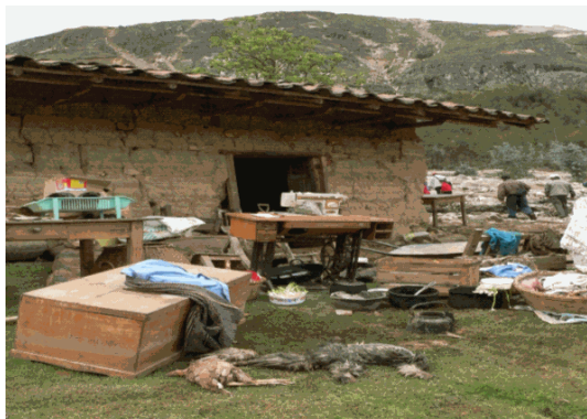
Figura 7 Vivienda colapsada a causa de las lluvias y huaicos
