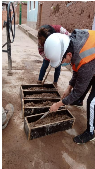
Figura 21. Fabricación de viguetas 2
