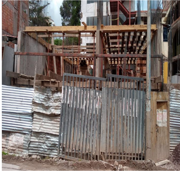
Figura 6. Obra de la ciudad de Cusco
