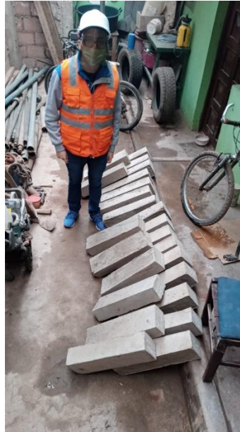
Figura 24. Curado de viguetas.
