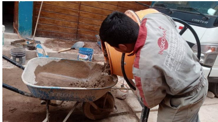
Figura 19. Vaciado del concreto.
