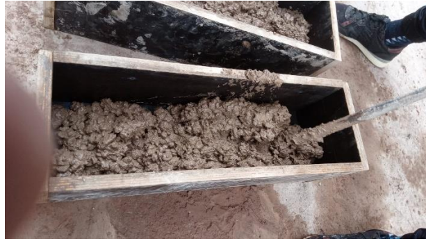
Figura 20. Fabricación de viguetas
