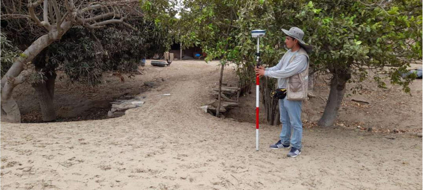
Foto 4: levantamiento de puentes.
