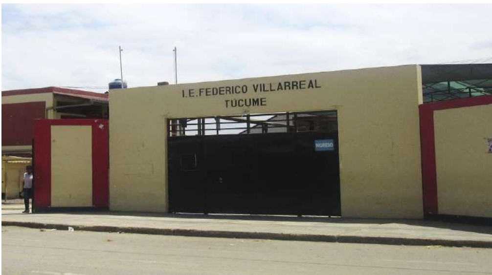
FOTOGRAFIA N° 07: Colegio emblemático del Distrito de Túcume
