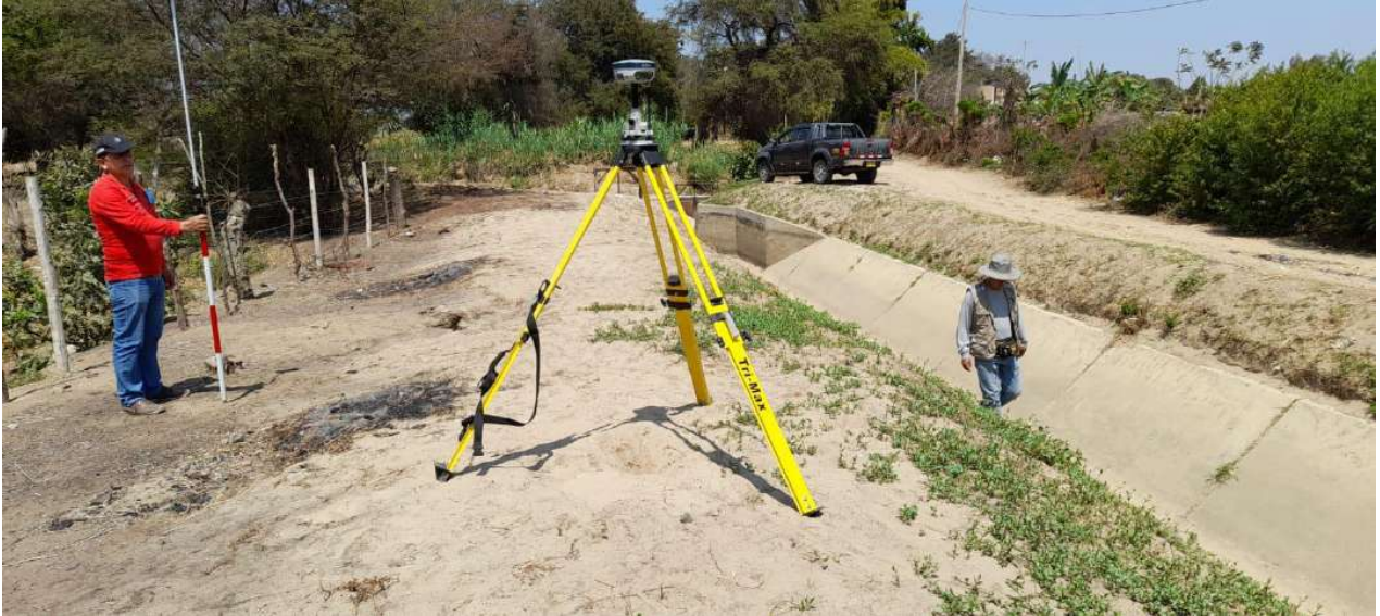
Foto N°:03 Equipo GNSS (GPS diferencial) estacionado como Base y brigada topográfica realizando el levantamiento topográfico en captación de canal de riego L2 Viuda
