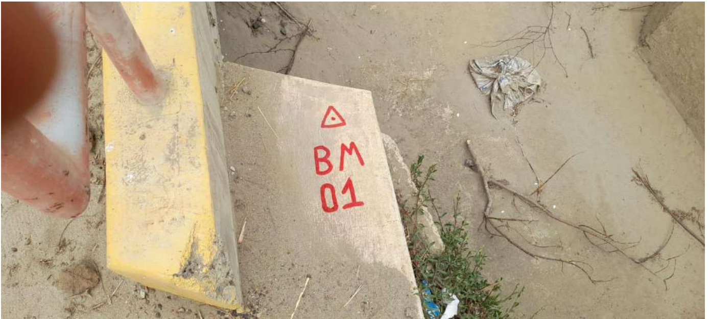
Foto 6: Marca de Bm en estructura existente
