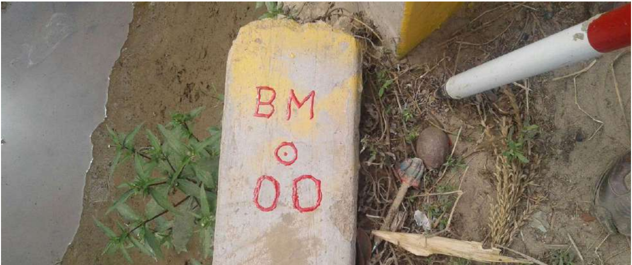
Foto N°:12 BM-00 establecido en estructura de concreto existente en Canal de riego L2 Higuieron
