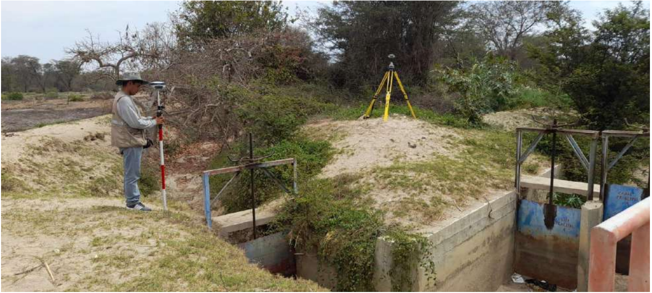
Foto N°:01 Equipo GNSS (GPS diferencial) estacionado como Base y brigada topográfica realizando el levantamiento topográfico en captación de canal de riego L2 Azalde
