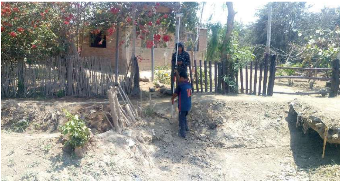
Foto N°:16 Levantamiento topográfico toma lateral rústica en canal L2 Sánchez
