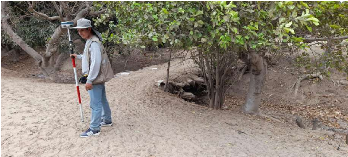
Foto N°:06 Levantamiento topográfico de puente peatonal rústico en canal de riego L2 Higuерón
