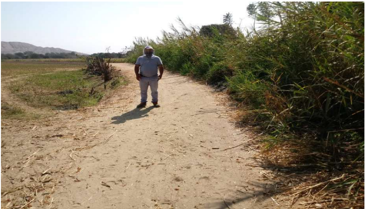
FOTOGRAFIA N° 03: CAMINOS DE VIGILANCIA SIN MANTENIMIENTO
