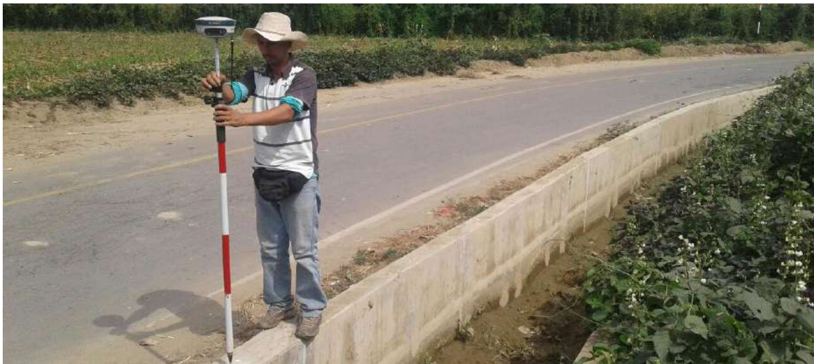
Foto N°:13 Levantamiento topográfico de revestimiento rectangular existente en canal L2 Higuieron
