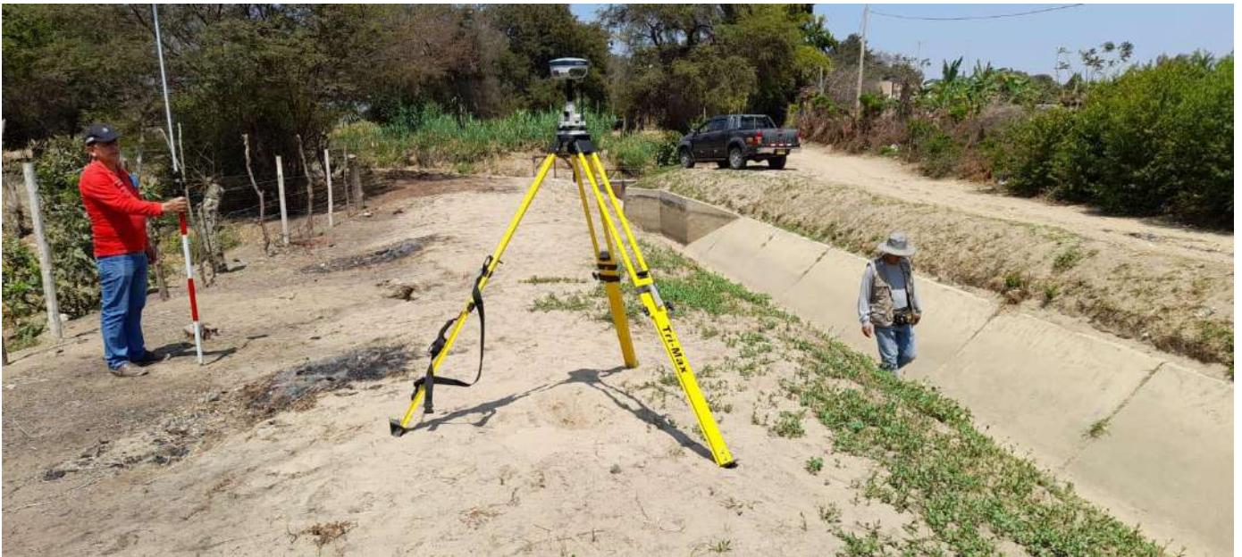
Foto 2: Posicionamiento de equipo GPS BASE.
