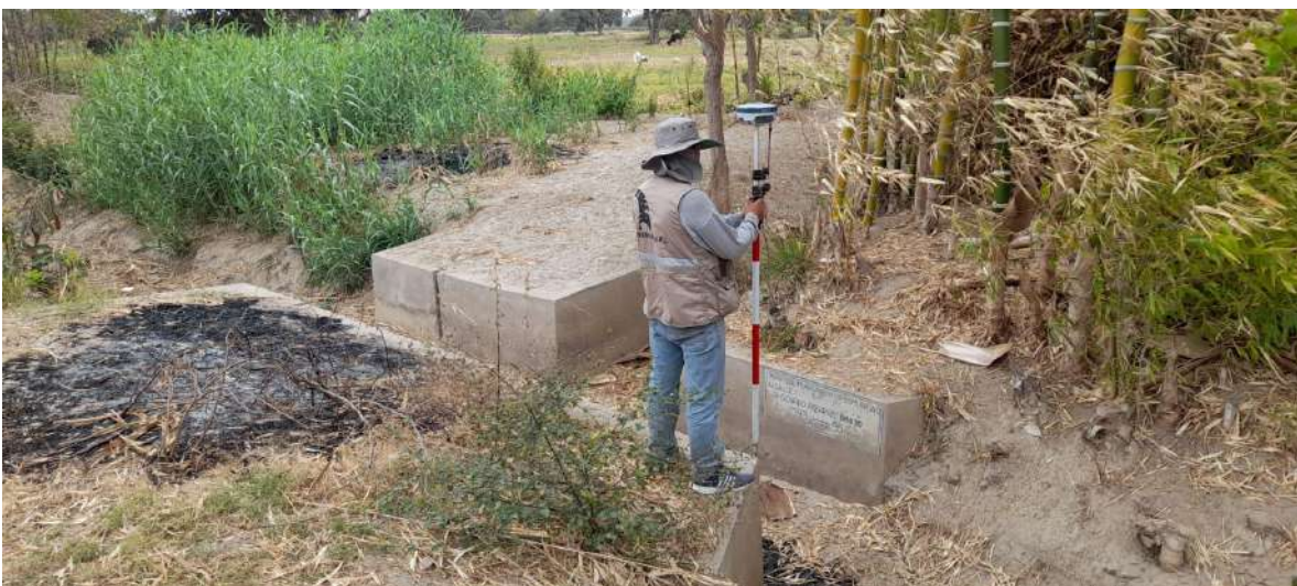
Foto N°:07 Levantamiento topográfico de toma lateral existente en canal de riego L2 Higuерón
