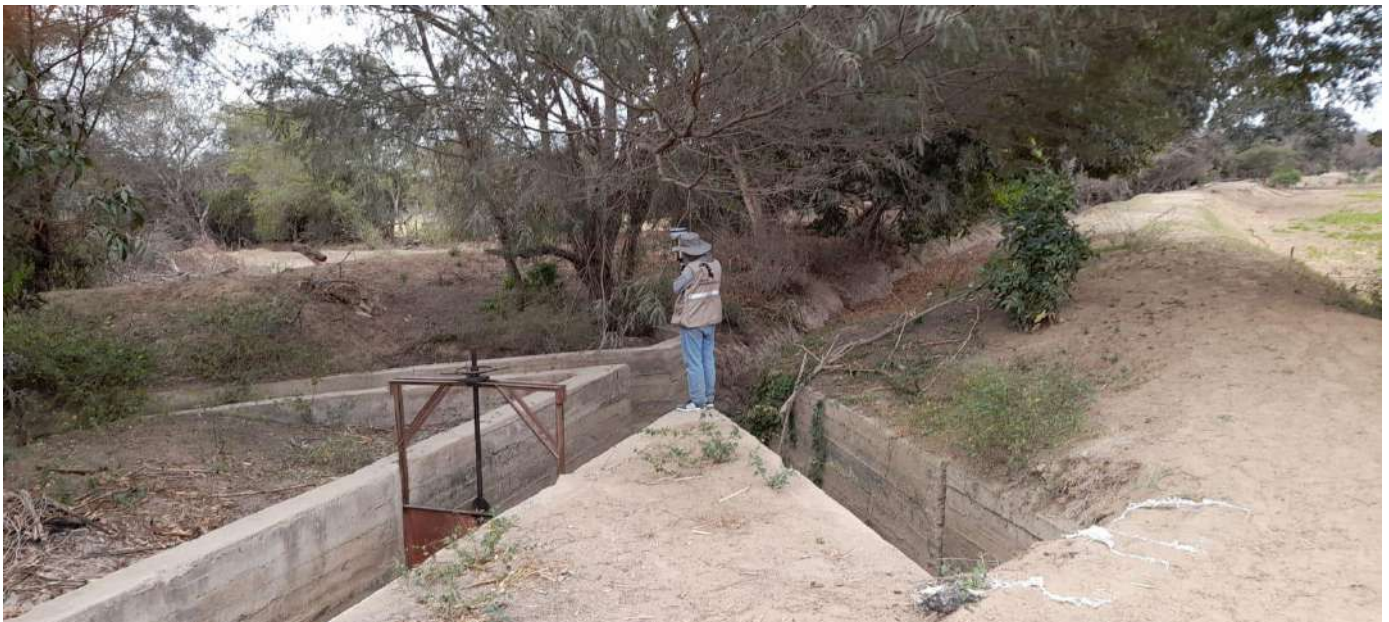
Foto 7: Marca de Bm en estructura existente
