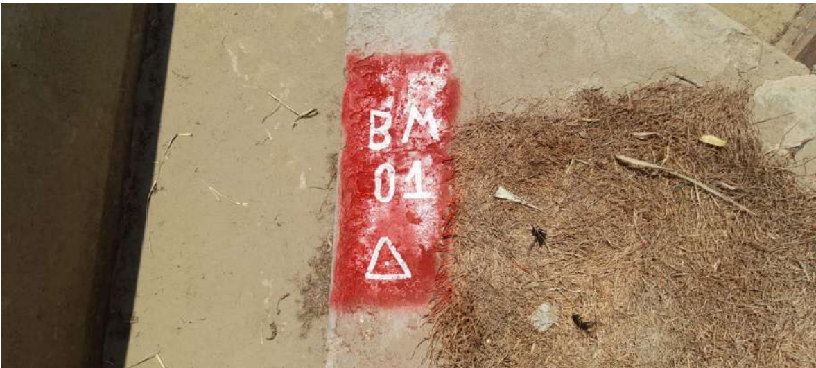
Foto N°:09 BM-01 establecido en estructura de concreto existente en Canal de riego L2 Viuda
