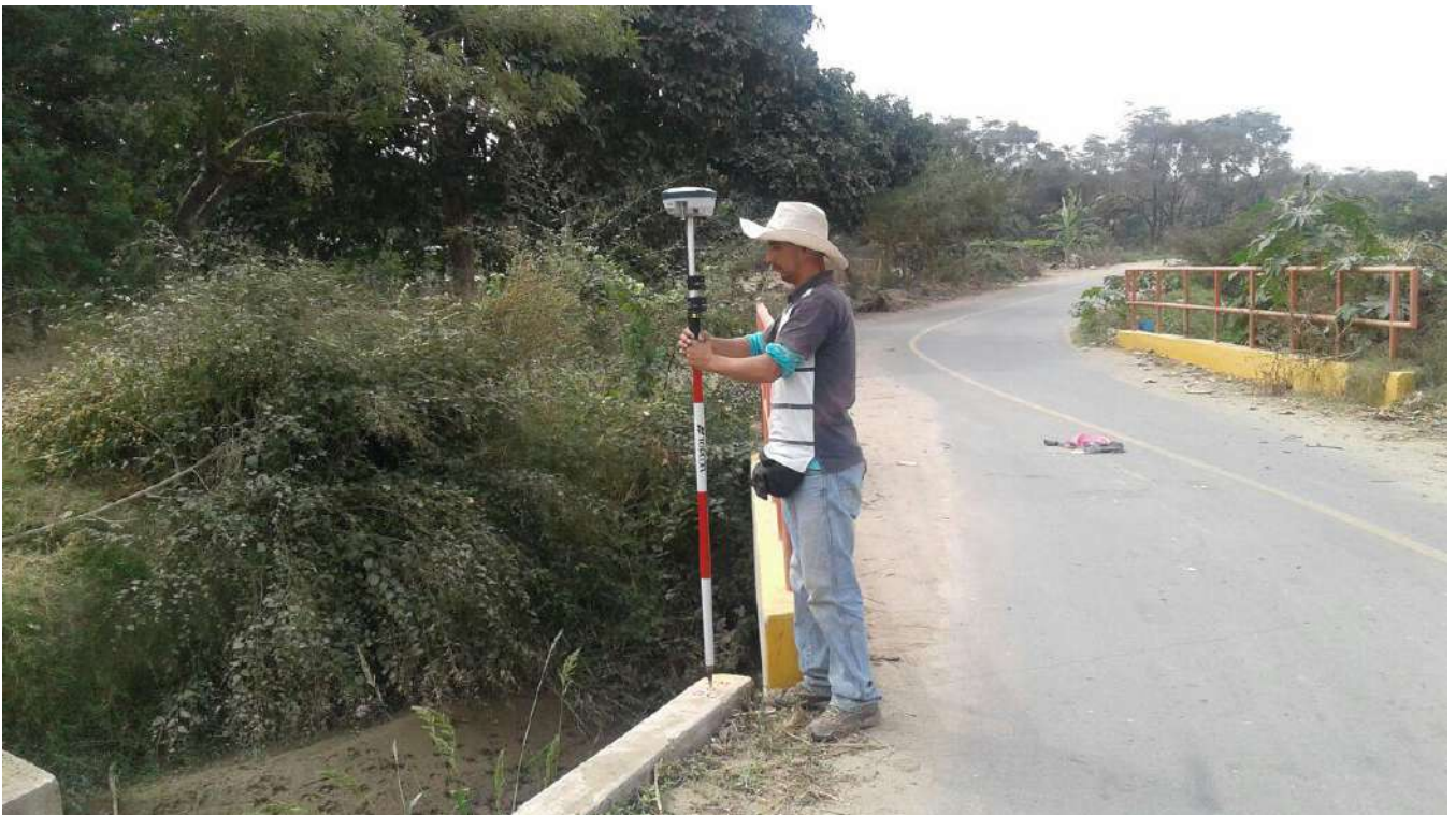
Foto N°:04 Lectura de BM-00 en Canal de riego L2 Higuierón
