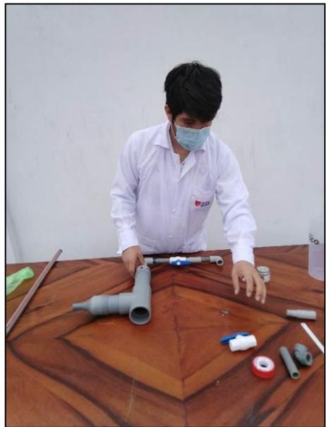
Fotografía 16: Ensamblado de llaves de ingreso al empaque del biofiltro.
