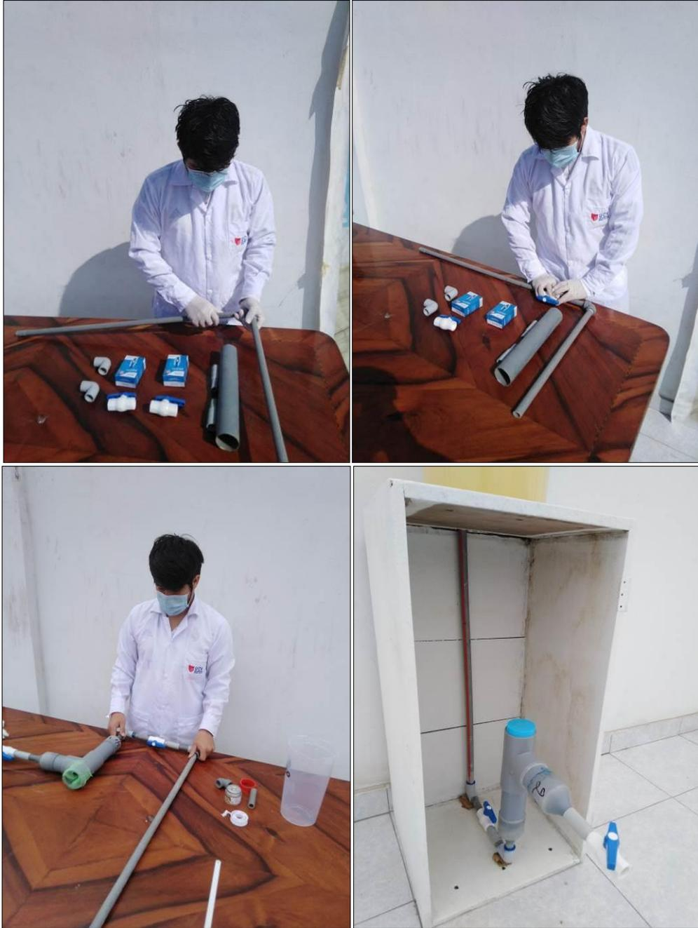
*Ilustración 9: Ensamblado del sistema de biofiltro.*
