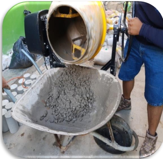
Fotografía 7: Se vuelve a elaborar el concreto para colocarlo en las probetas.
