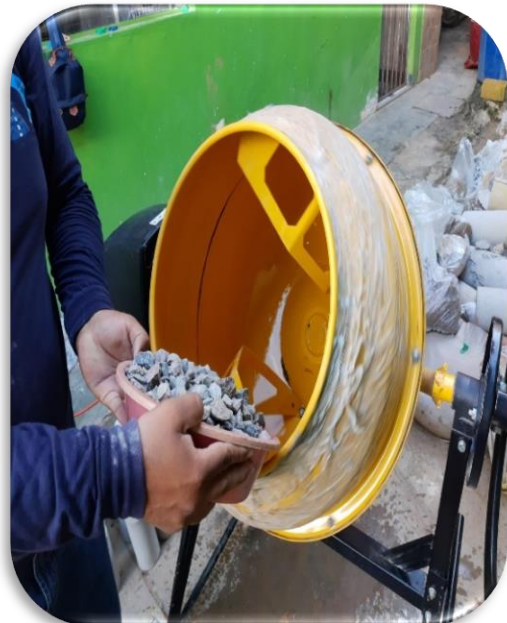
Fotografía 4: Se observa la colocación de piedra chancada de 1/2" y 3/4"
