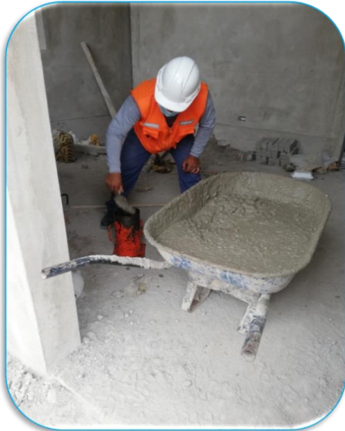
Fotografía 2: Se observa la elaboración de una probeta de concreto f'c 210 kg/cm 2
