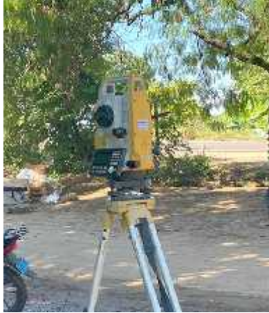
Estación total utilizada en el levantamiento topográfico.
