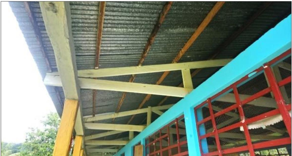
Módulo de infraestructura de ladrillo con cobertura de calamina en pésimas condiciones
