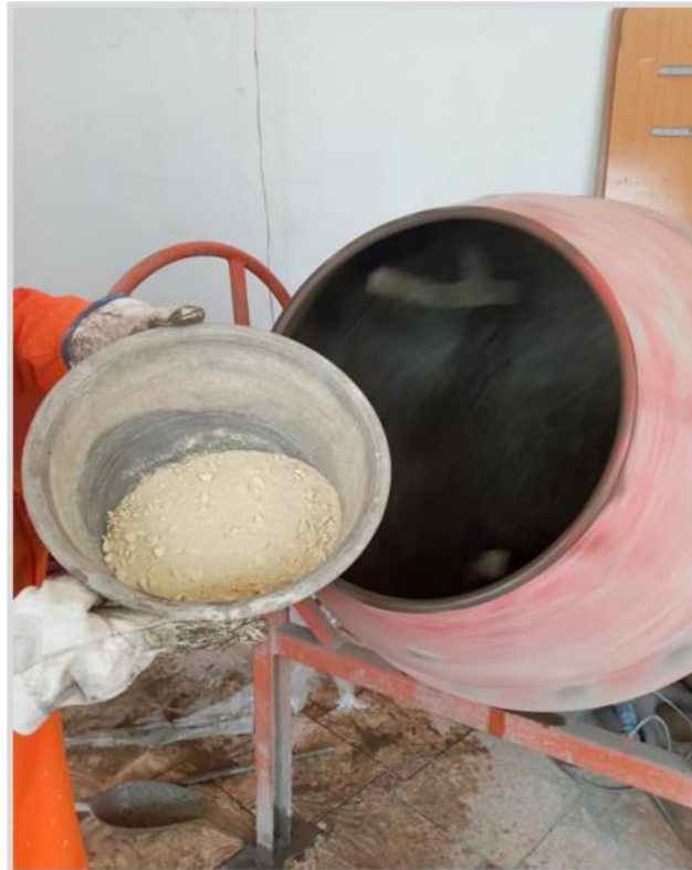
Figura 20. Mezclado del concreto de diseño
