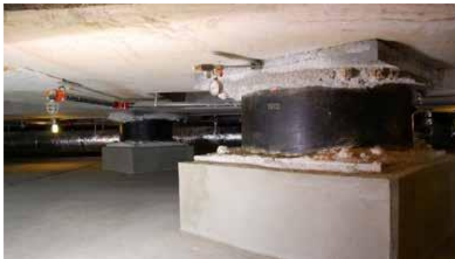
Figure 2: implementación de aisladores, en base estructural
