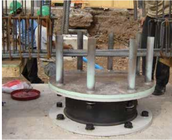
Figura 5 Aislador sísmico elastomérico
