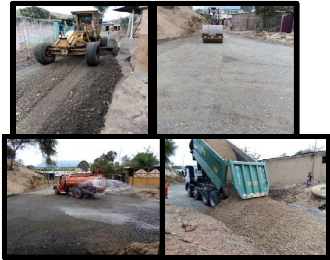
Figura 15. Preparación de la Sub Base y Base
