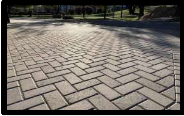
Figura 11. Pavimento Intertrabado Fuente: Héctor Magnone
