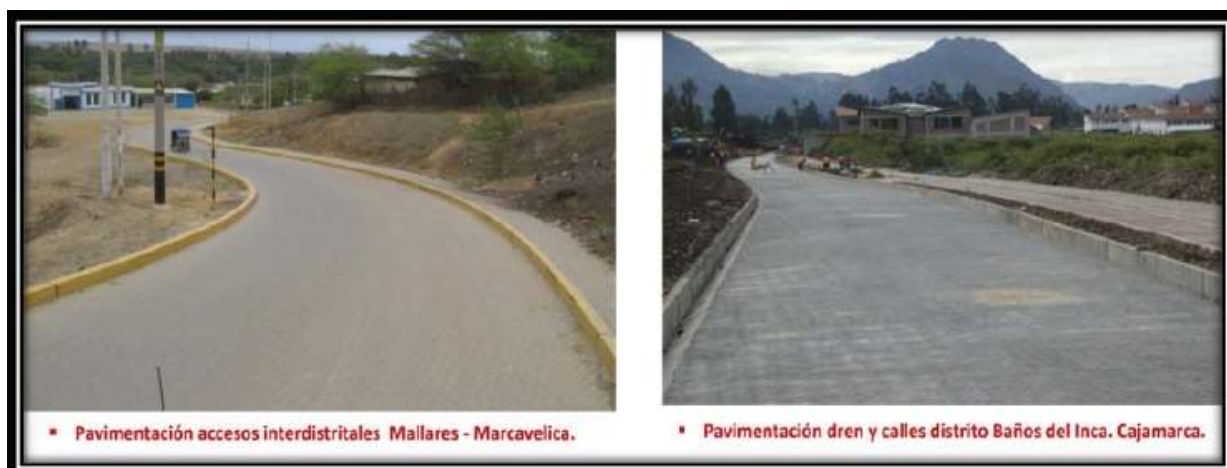
Figura 5. Pavimentos con Drenaje
