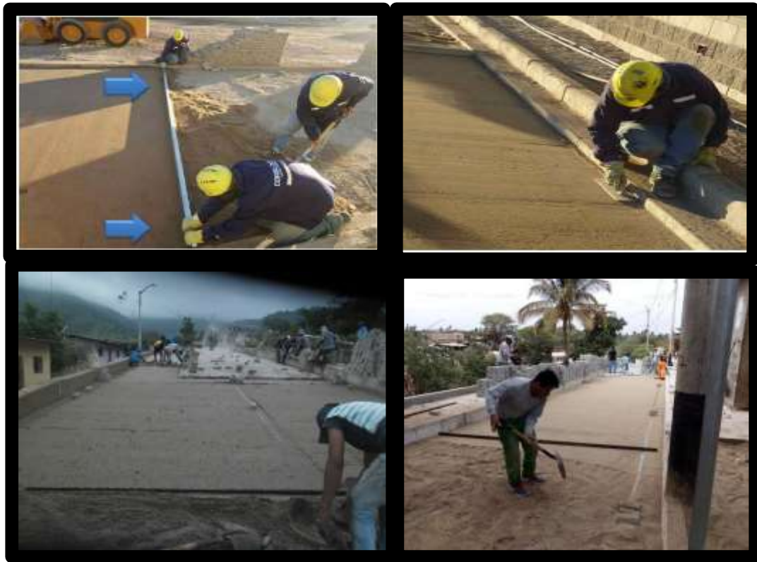
Figura 16. Procedimiento para extender la capa de arena
