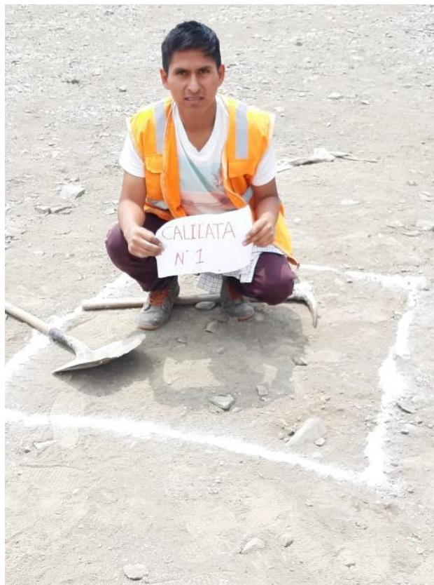
Foto 4: Calicata N° 1 en la Empresa Transporte San Ignacio s.a
