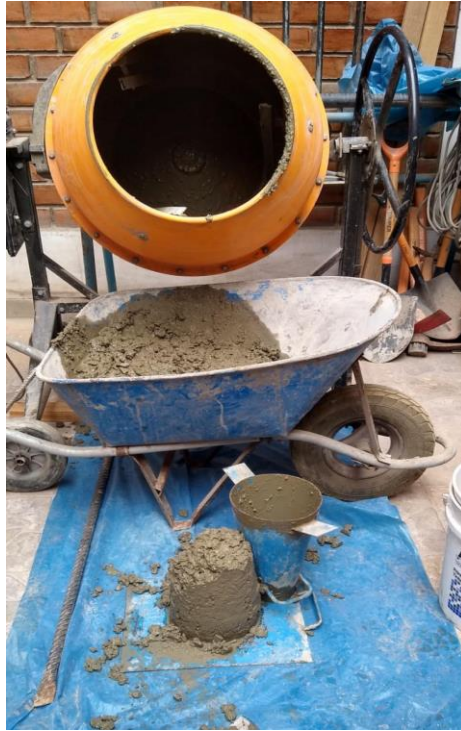
Foto 19: Mezcla de Concreto, para determinar su asentamiento.
