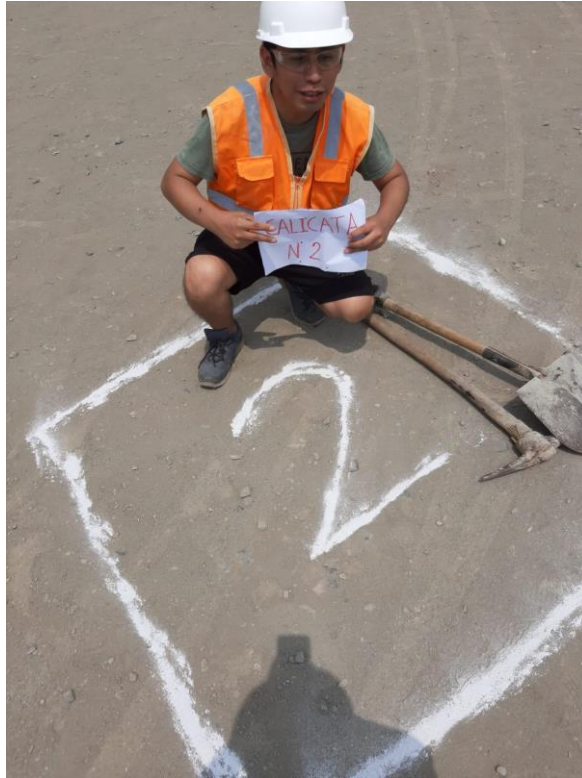
Foto 5: Calicata N° 2 en la Empresa Transporte San Ignacio s.a
