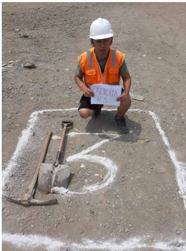
Foto 6: Calicata N° 3 en la Empresa Transporte San Ignacio s.a
