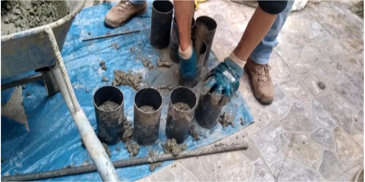
Foto 22: Elaboración Probetas de concreto.
