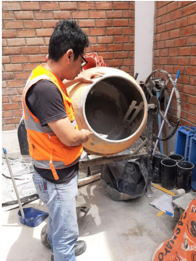
Foto 18: Preparación de Mezcla con el equipo Trompito
