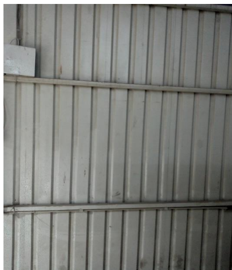
Figura 9. Área de Habilitado antes de la abertura B
