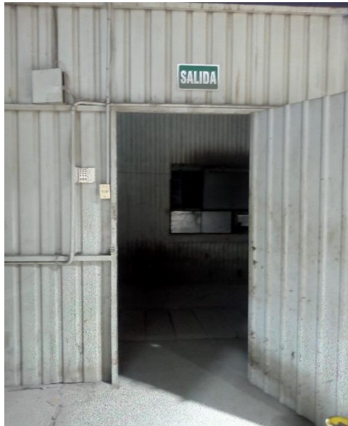
Figura 10. Área de Habilitado después de la abertura B
