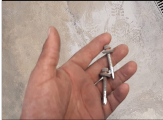
Figura 11. Tornillo autorroscante desgastado
