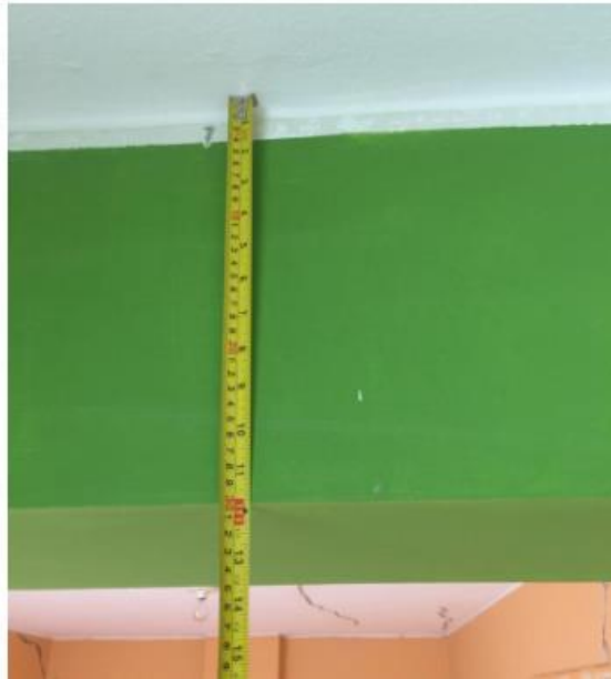
Figura 7: Peralta de la viga 50x25cm
