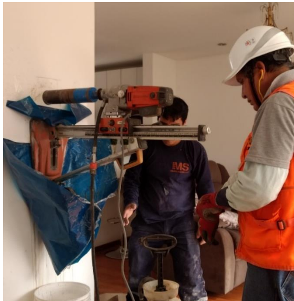
Figura 13: Extracción de diamantina de la columna
