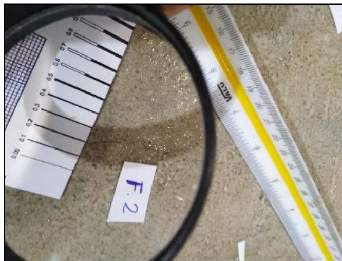
Figura 35. Fisura a las 24 horas - muestra patrón
