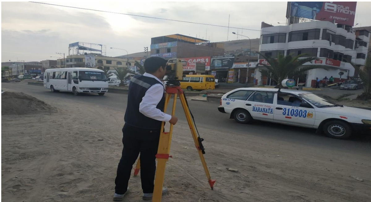
Figura N°21- levantamiento topográfico de la Av-Jorge Basadre
