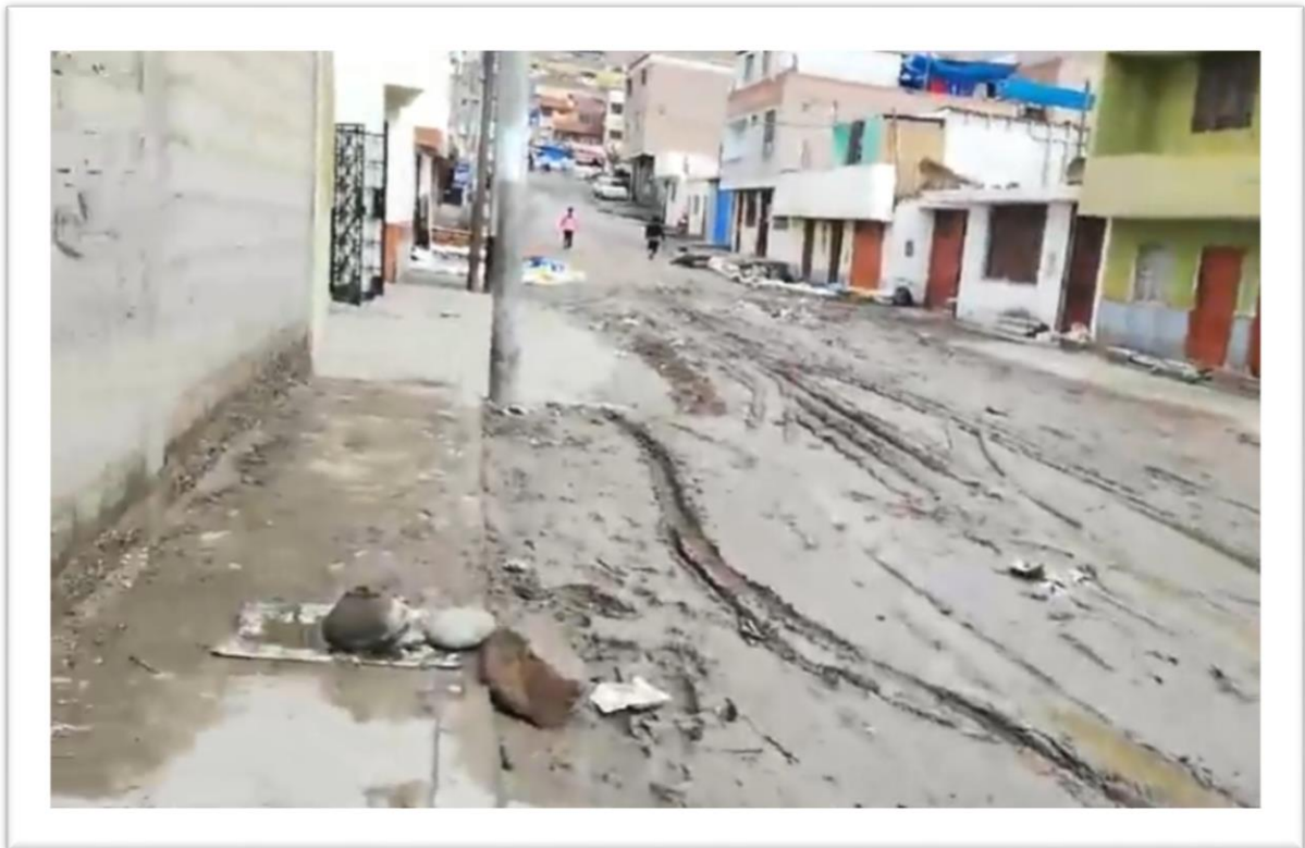
Figura N°16- aniego pluvial en la Av. De 28 agosto Fuente: Aatoria Propia
