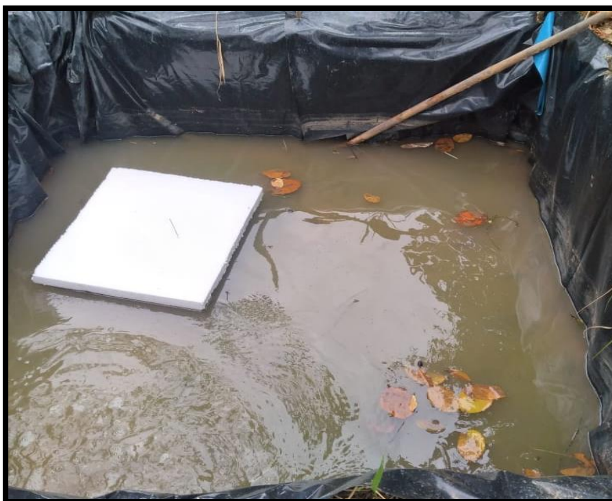
Anexo N° 8. Llenado de agua de la quebrada Indañe al humedal artificial.
