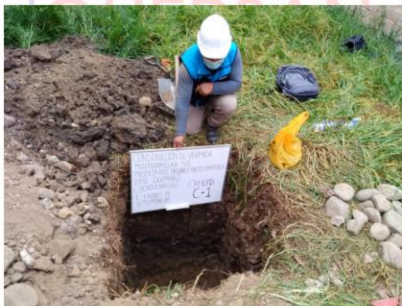
Fotografia N° 04. Vista General de la calicata C – 1.
