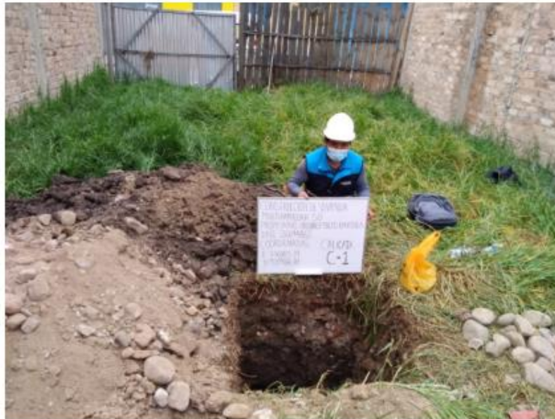
Fotografía N° 01. Vista General de la calicata C – 1.
