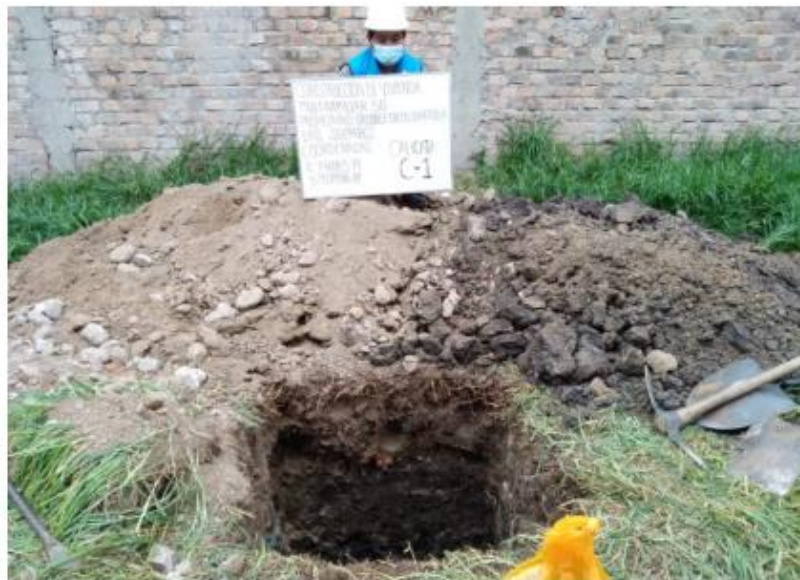
Fotografía N° 05. Vista General de la calicata C – 1.
