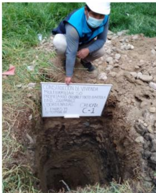
Fotografia N° 03. Vista General de la calicata C – 1.
